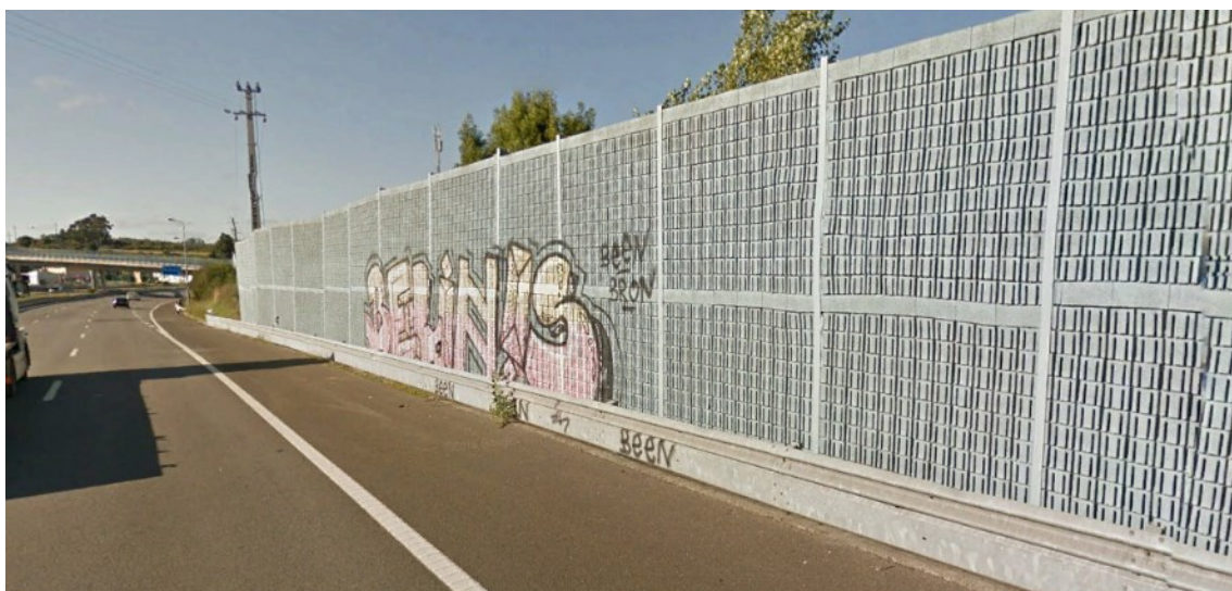
Imagem 3: Barreira de Blocos de alvenaria
