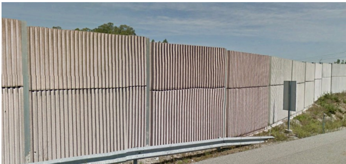
Imagem 4: Barreira de betão
