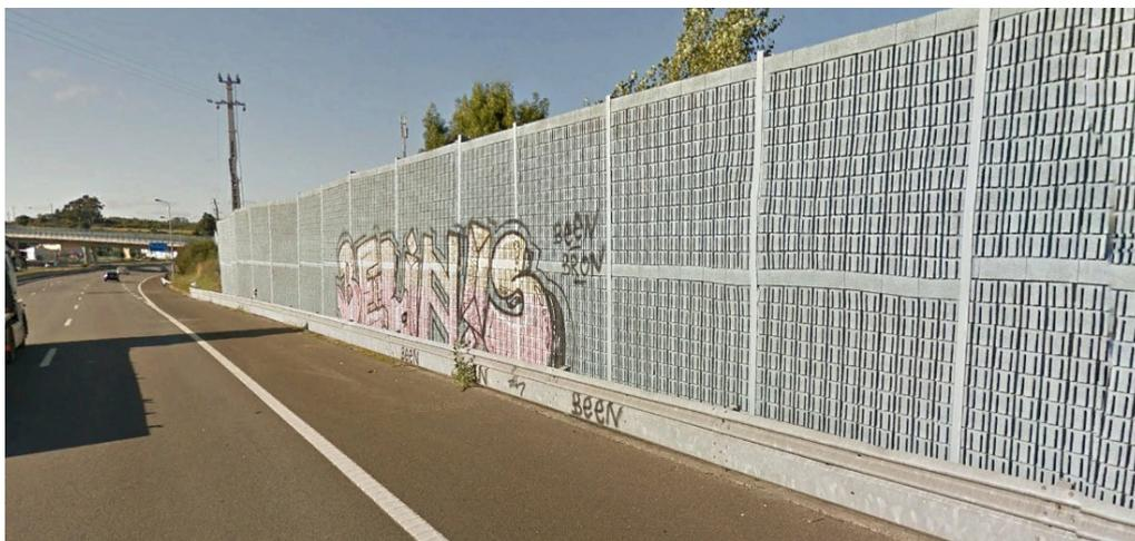
**Imagem 3: Barreira de Blocos de Alvenaria**
