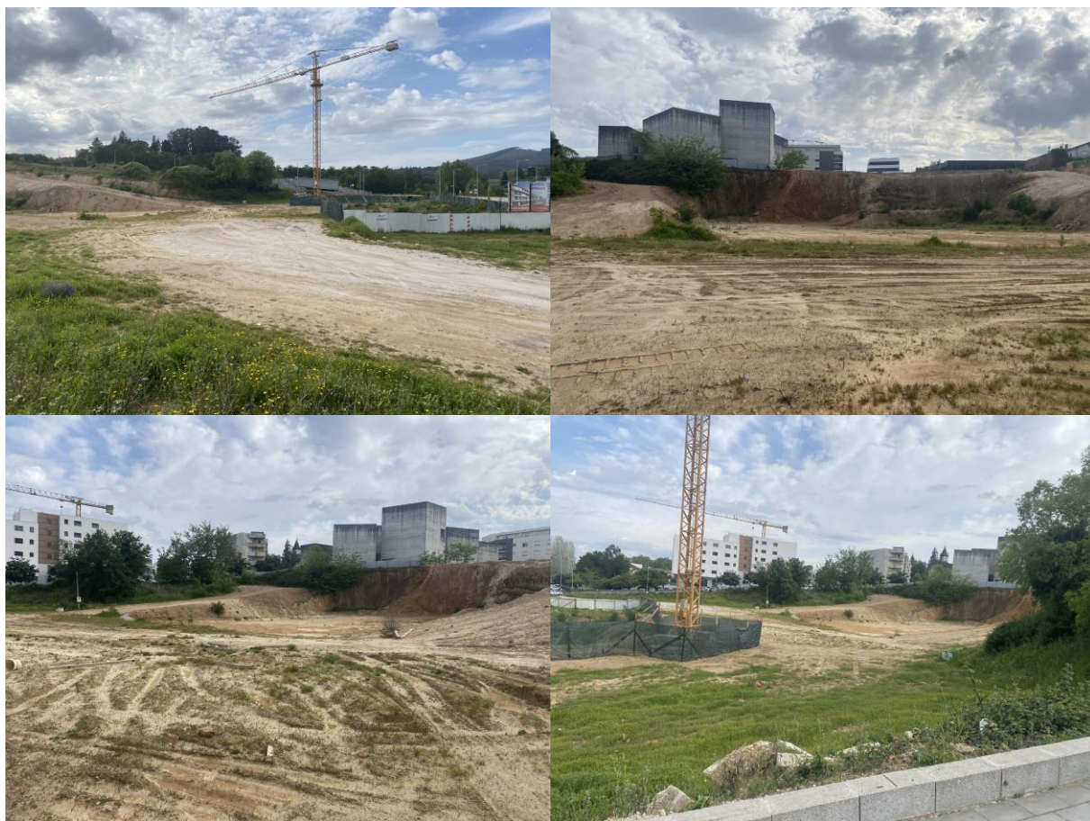
Fotografias do estado anterior à intervenção
