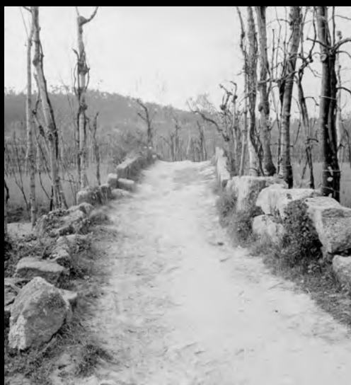
Figura 5. Vista do tabuleiro e calçada da Ponte da Veiga na margem direita. (1962) (IHRU, 1962 apud Resende, 2014, p. 429).
