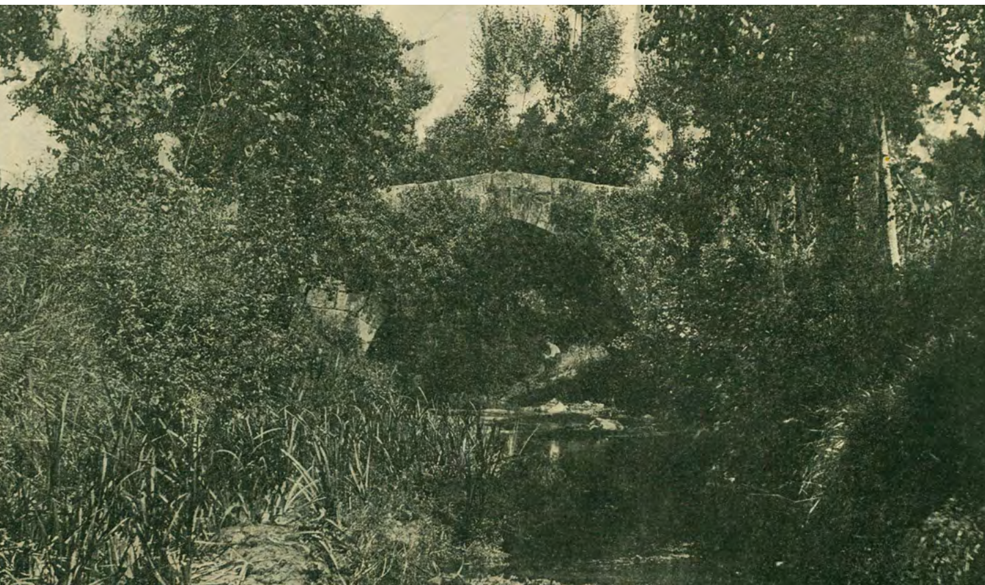
Figura 3. Aspeto do arco jusante da Ponte da Veiga na década de 30 do século XX (S.a. 1935, p. 448).
