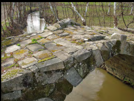
Figura 12. Vista parcial do arco montante e tabuleiro da Ponte da Veiga (2006).
