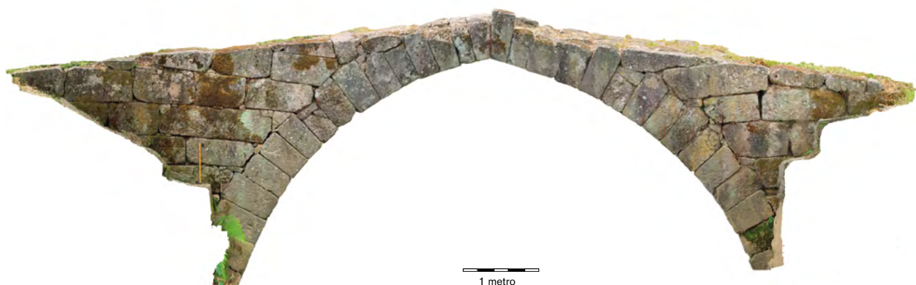
Figura 16. Imagem ortofotogramétrica composta pelo arco montante e arranques laterais da Ponte da Veiga (2023) (João Teixeira Marques).
