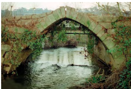
Figura 7. Arco jusante da Ponte da Veiga (1996) (Serenho e Amaral, 1996).
