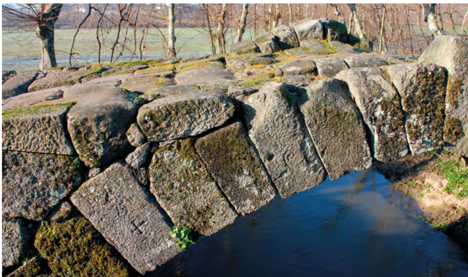
Figura 24. Pormenor do arco montante da Ponte da Veiga com a presença de marcas de colocação espiraliforme e cruciforme.
