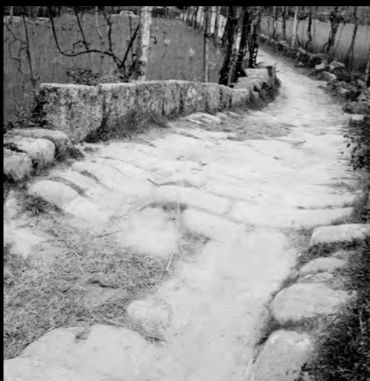
Figura 6. Vista do tabuleiro e da calçada de acesso à ponte a partir da margem esquerda (1962) (IHRU, 1962 apud Resende, 2014, p. 429).
