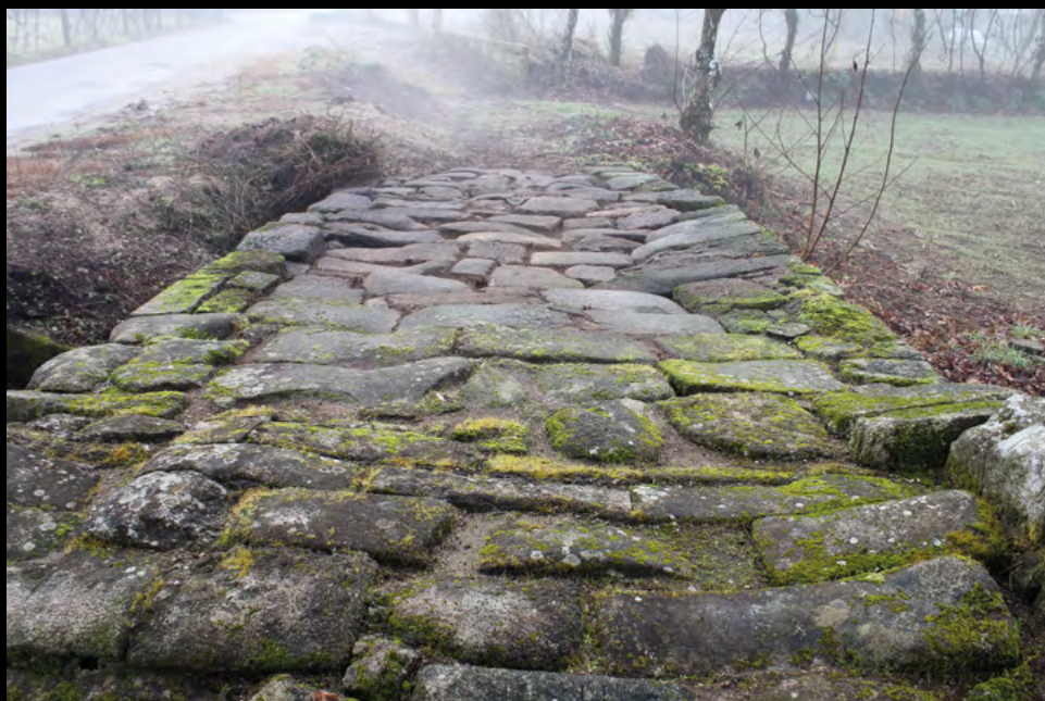
Figura 15. Tabuleiro e calçada da margem esquerda da Ponte da Veiga vistos a partir da fiada de fecho do arco (2012).
