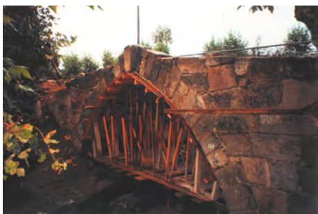
Figura 9. Vista do arco jusante com a respetiva armação de suporte, em madeira, durante as obras de recuperação da Ponte da Veiga (CML, 2000, p. 115).
