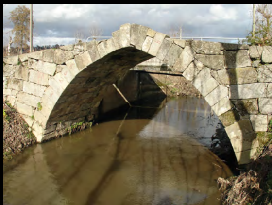
Figura 11. Vista do arco jusante da Ponte da Veiga (2006).
