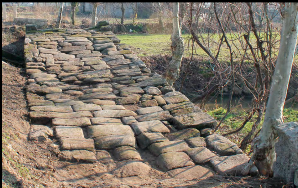
Figura 14. Calçada e tabuleiro da Ponte da Veiga vistos a partir da margem direita (2012).
