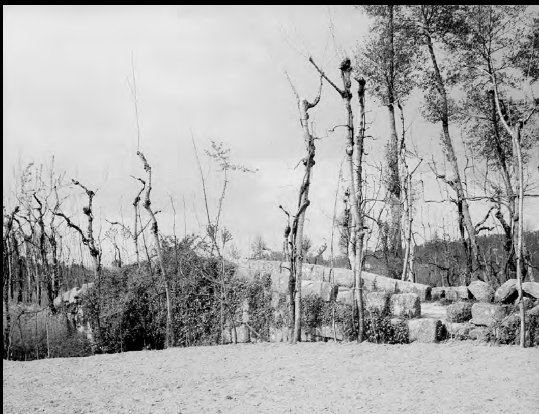
Figura 4. Ponte da Veiga vista de jusante (1962) (IHRU, 1962 apud Resende, 2014, p. 419).
