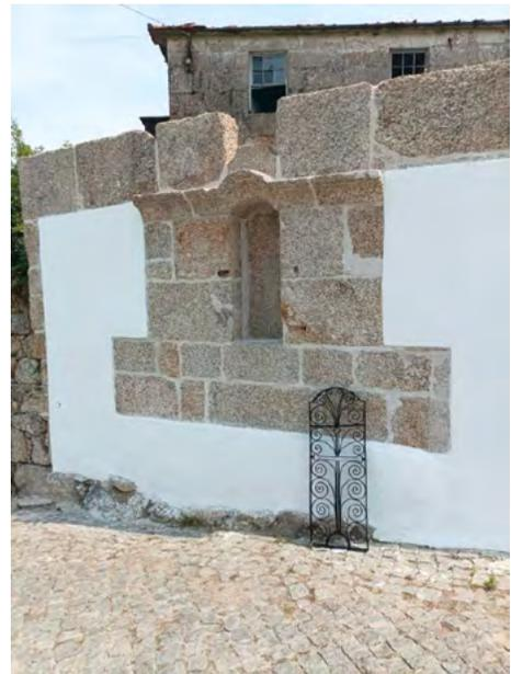
**Figura 22.** Aspeto final do reboco e colocação dos elementos metálicos das alminhas do Alves (Dalmática, 2022b).
