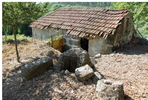
**Figura 3** Vista geral do Moinho de Infesta (n.º inv. 244) e respetivo cubo com grade metálica.
