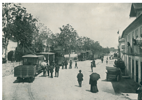
Figura 24. Manobras de comboios na Vila de Lousada (Companhia Auxiliar de Construções Ferro-Viárias, 1914).
