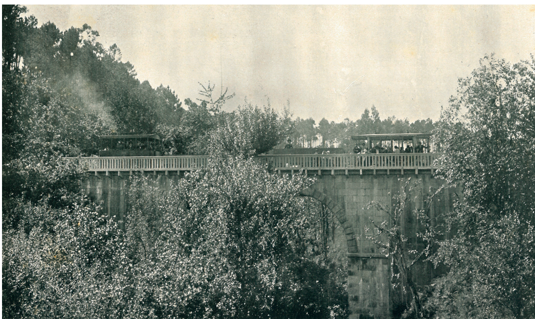
Figura 29. Passagem de comboio sobre a ponte de São Miguel de Lousada (Companhia Auxiliar de Construções Ferro-Viarias, 1914).
