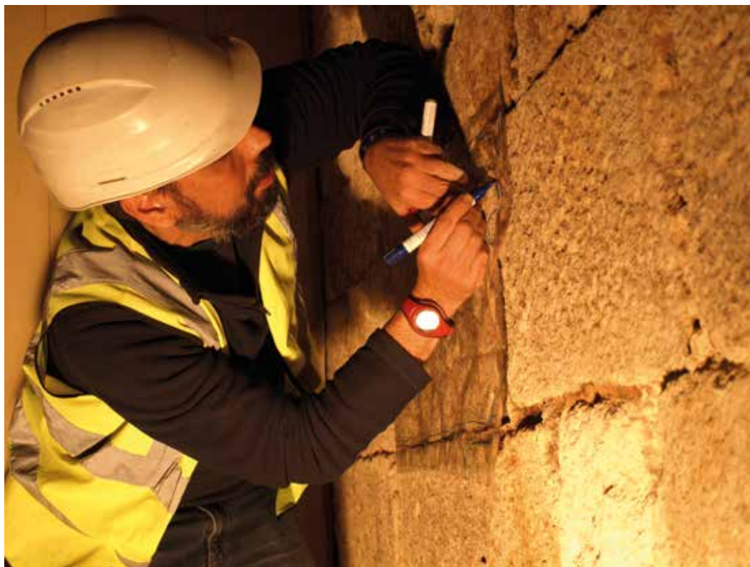
Figura 9. Levantamento parietal das marcas de canteiro com manga plástica/acetato.
