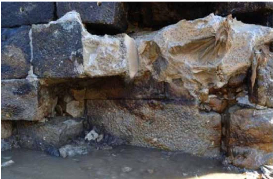
**Figuras 14 e 15** Vista geral do talha-mar do pilar 2, em fase de reabilitação, e pormenor do talha-mar *antigo*, pré-existente.
