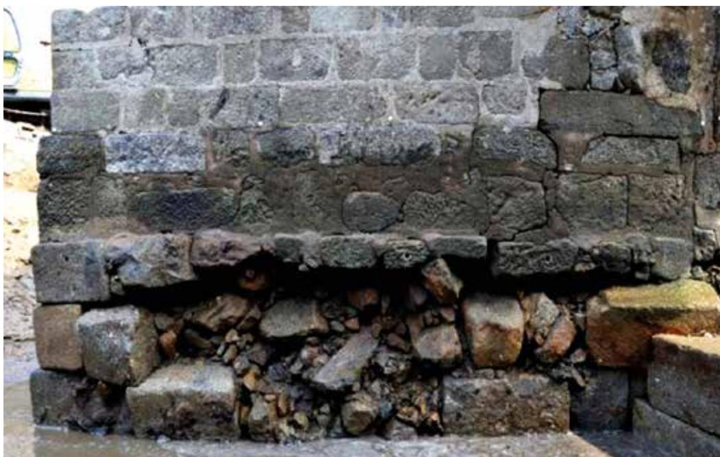
**Figuras 16 e 17** Vista geral das estruturas identificadas no pilar 3 e pormenor do seu contraforte, em avançado estado de degradação.
