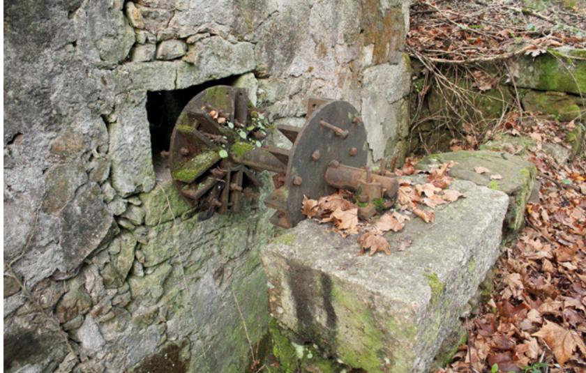
**Figura 4** Aspecto da abertura e gola onde assenta o eixo metálico ao qual se fixavam os braços da roda vertical da azenha (Moinho de Lourosa 2; n.º inv. 145).
