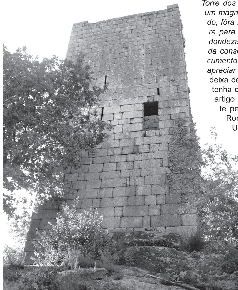
Fig. 3 Alçado sudeste antes da intervenção de restauro.
