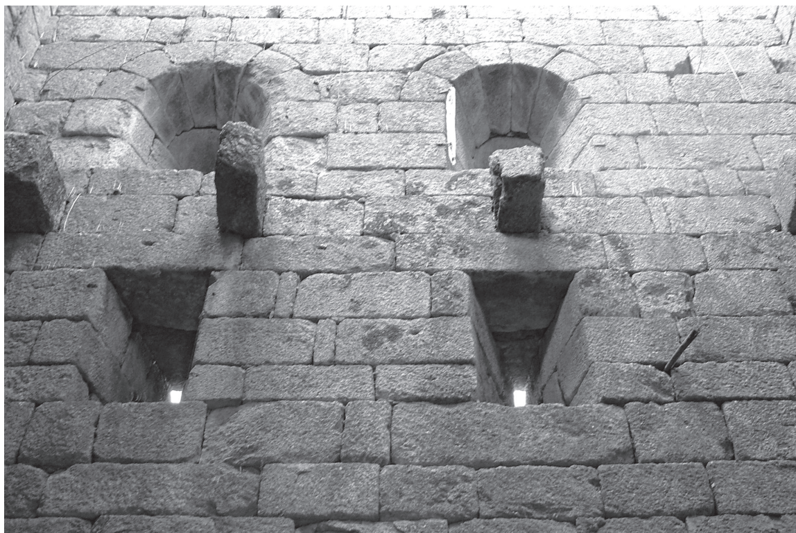
Fig. 2 Interior da Torre de Vilar antes da intervenção de restauro.
