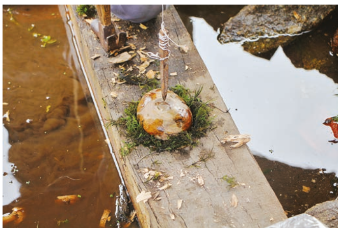
FIGURA 123. Preenchimento da concavidade de assentamento da rela com musgo.
