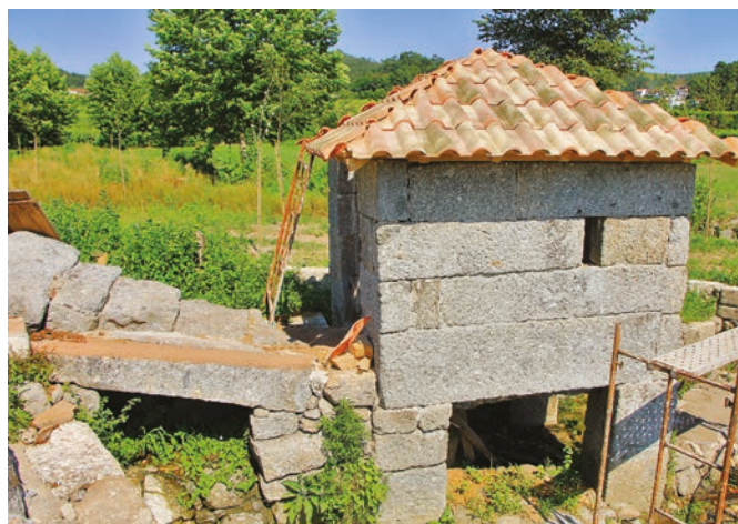
FIGURA 68. Pormenor dos trabalhos de cobertura do moinho com telha cerâmica.
