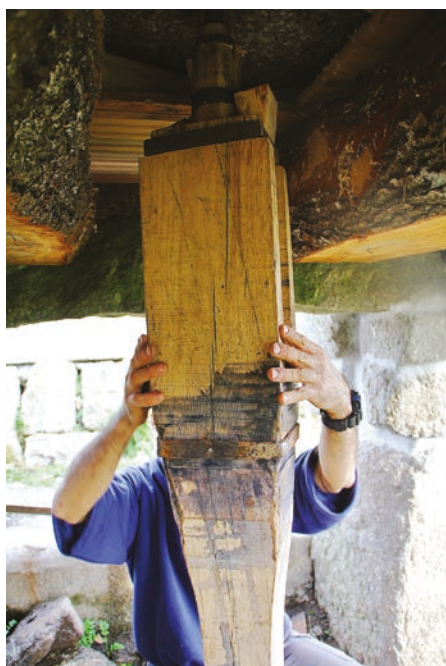
FIGURAS 141 E 142. Ação de montagem da pela, do lobete e do rodízio nos caboucos do moinho.
