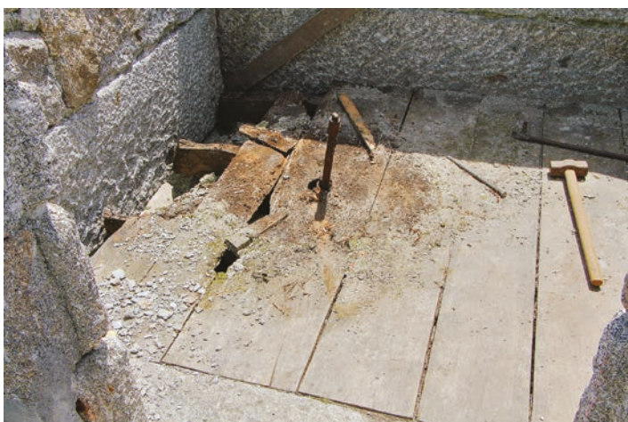
FIGURA 84. Trabalhos de remoção do mecanismo de moagem.
