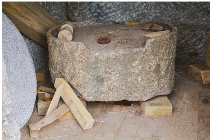
FIGURA 88. Pormenor da mó dormente após a sua reposição no interior do moinho.
