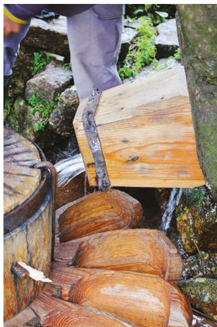
FIGURA 148. Pormenor da fixação da nova seteira ao cubo através de um aro metálico.
