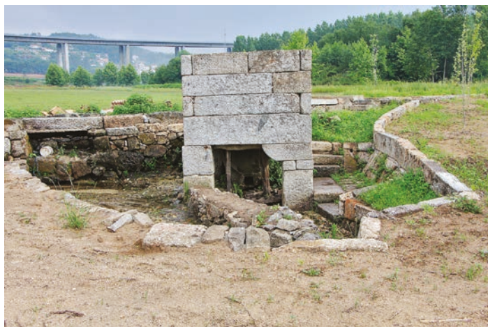
FIGURA 62. Aspecto final da presa após as ações de reconstrução (vista de sul).
