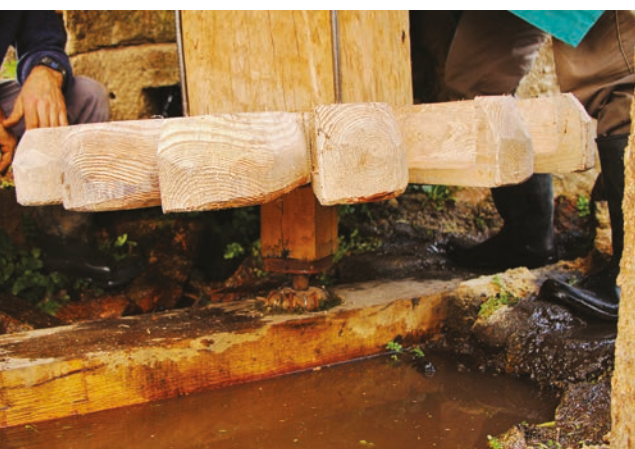
FIGURA 143. Pormenor do novo rodízio montado na ponte.
