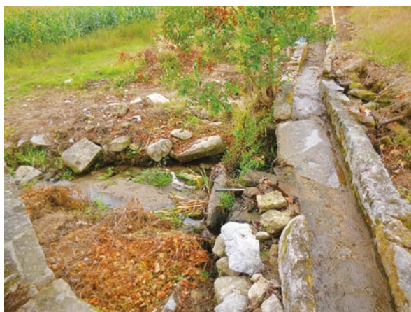
FIGURA 20. Pormenor do sistema de condução após as ações de desmatção da vegetação arbustiva.
