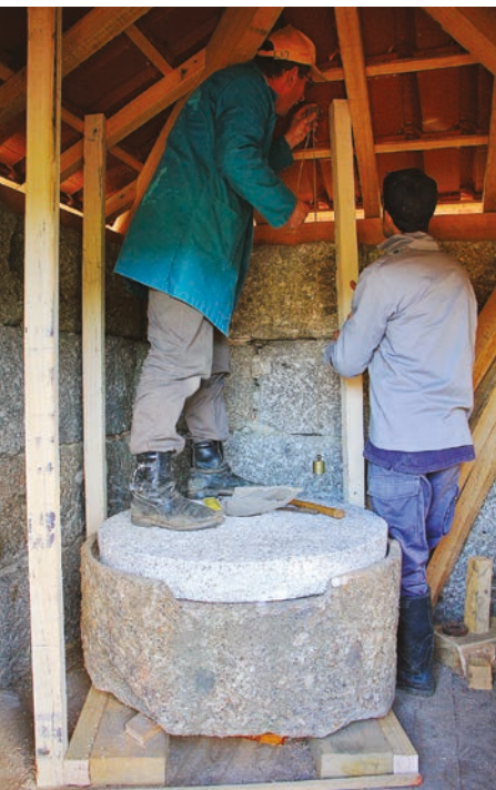
FIGURAS 97 E 98. Trabalhos de montagem da estrutura de apoio da dorneira, da quelha e da chamadaeira.
