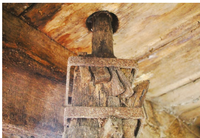
FIGURA 112. Pormenor do encaixe da pela com o lobete.
