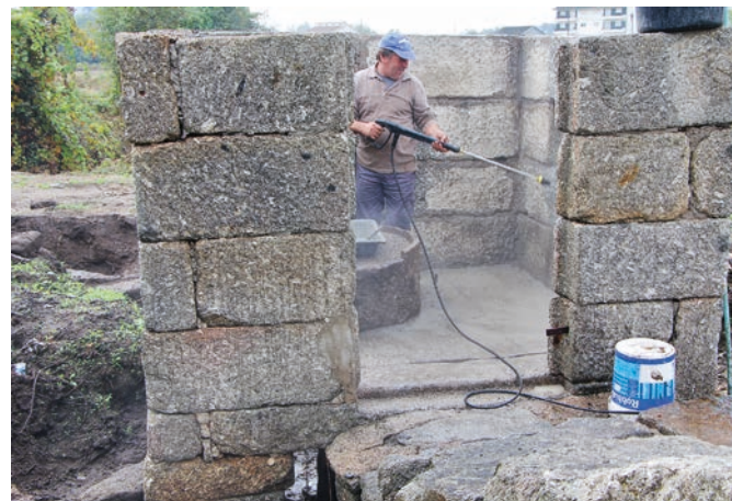
FIGURAS 26 E 27. Trabalhos de limpeza com jato de água no exterior e interior do moinho.
