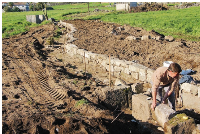
FIGURAS 41, 42, 43 E 44. Trabalhos de reconstrução dos muros que ladeiam a levada nas imediações do açude.
