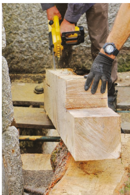
FIGURAS 71 A 75. Trabalhos de colocação das novas travessas de madeira no piso de moagem.
