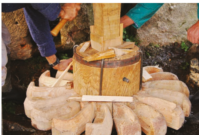
FIGURA 144. Trabalhos de nivelamento do novo rodízio.
