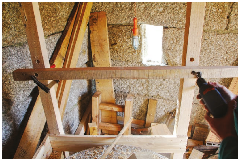
FIGURAS 97 E 98. Trabalhos de montagem da estrutura de apoio da dorneira, da quelha e da chamadaeira.
