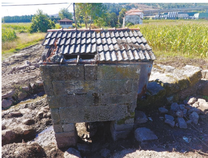
FIGURA 63. Aspecto do sistema de cobertura do moinho no início dos trabalhos.
