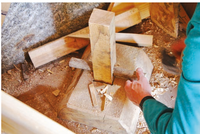
FIGURA 109. Trabalhos de aplicação dos calços do alçadoiro.
