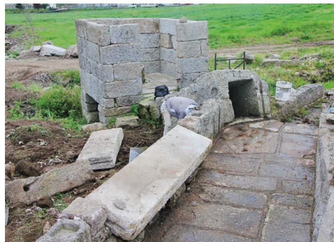
FIGURAS 48 E 49. Pormenor dos trabalhos de reconstrução da escadaria de acesso à ponte, erigida a montante do lavadouro.
