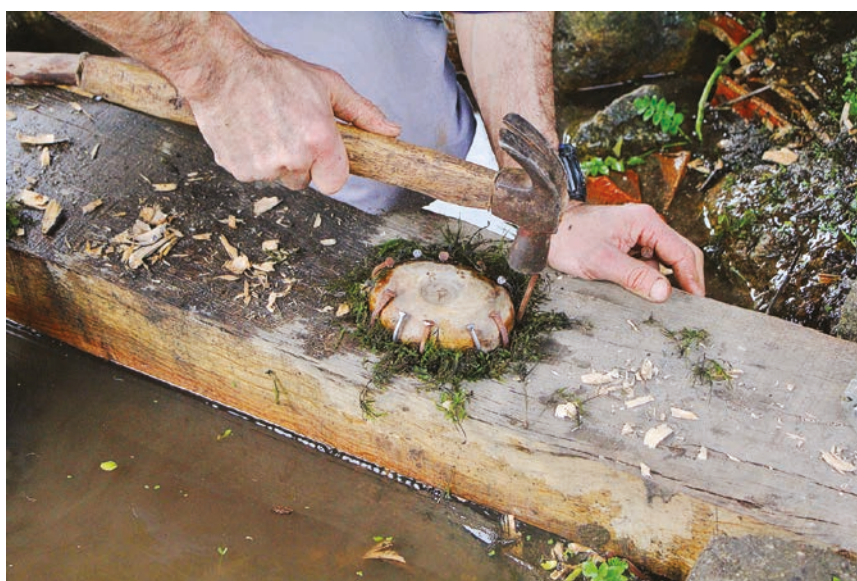
FIGURA 124. Trabalho de fixação da rela à ponte.
