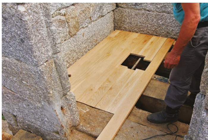
FIGURA 76. Trabalhos de colocação do novo piso de madeira.
