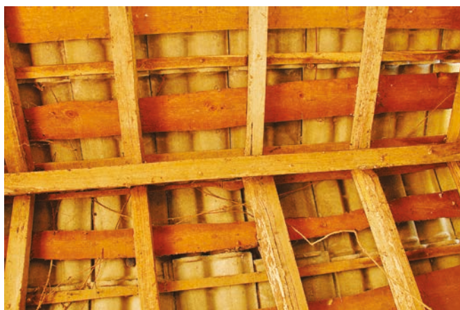
FIGURA 64. Pormenor do sistema de cobertura do moinho no início dos trabalhos (interior).
