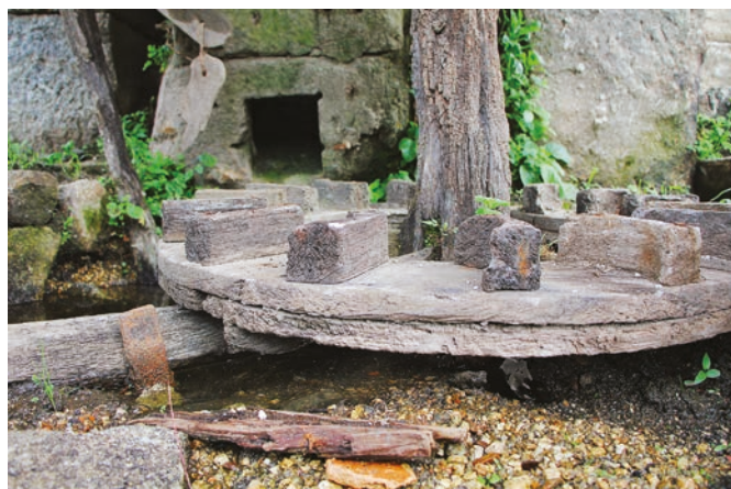
FIGURA 113. Pormenor do rodízio de tacos e respetiva ponte.
