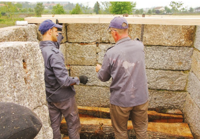
FIGURA 87. Trabalhos de recolocação da mó dormente no interior do moinho.
