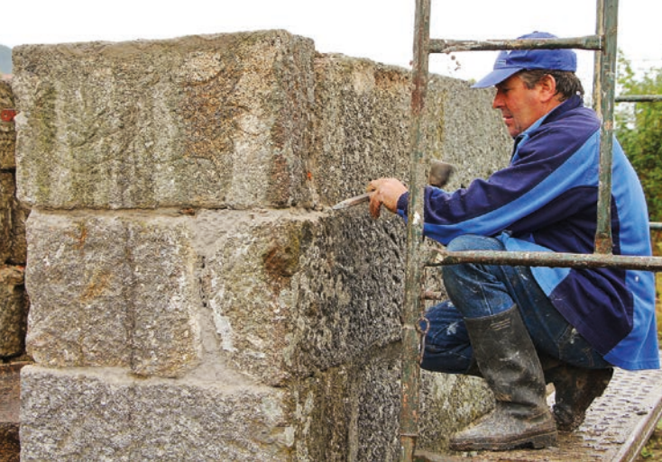
FIGURA 28. Trabalhos de picagem dos excedentes das juntas do aparelho do moinho.
