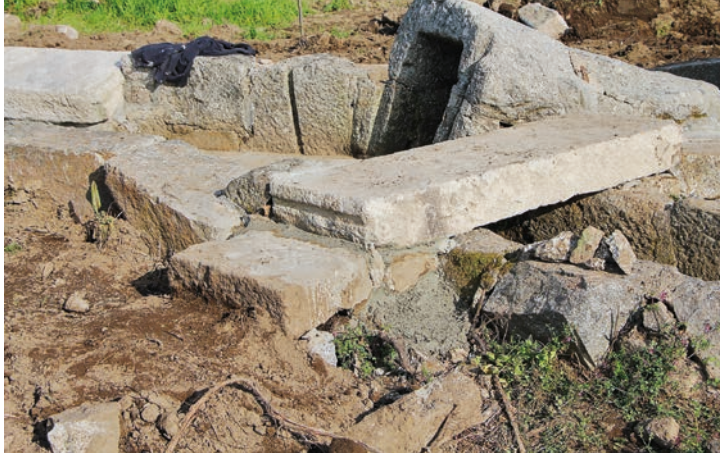
FIGURA 47. Pormenor da ponte que transpõe a levada e que serve de acesso ao moinho.
