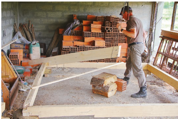
FIGURA 65. Pormenor do sistema de cobertura do moinho (interior).
