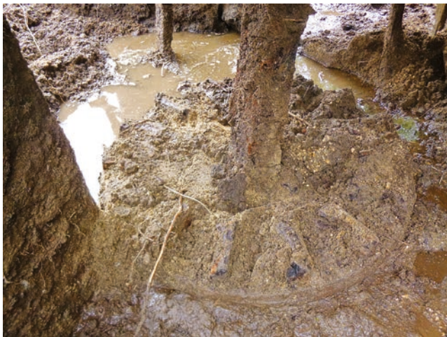
FIGURA 25. Pormenor dos caboucos após os primeiros trabalhos de limpeza.
