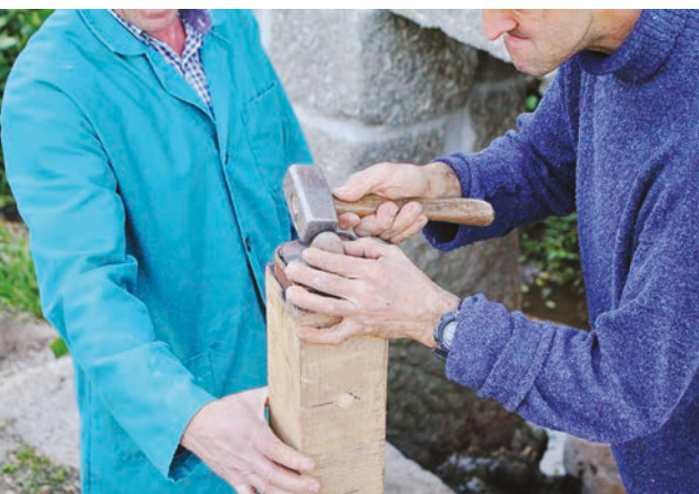
FIGURAS 129 E 130. Fixação do agulhão na base da pela.
