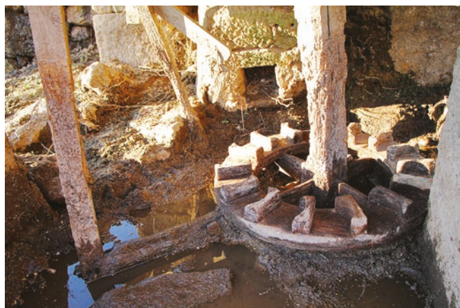
FIGURA 111. Aspeto dos elementos originais do mecanismo motor do moinho: pela, rodízio, ponte, alçadoiro e pejadoiro.
