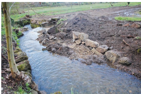
FIGURAS 36 E 37. Reconstrução do muro na margem direita do rio Mezio, a montante do açude.
