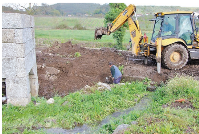
FIGURA 23. Trabalhos mecânicos de remoção das terras na envolvente sudoeste a nordeste do moinho.
