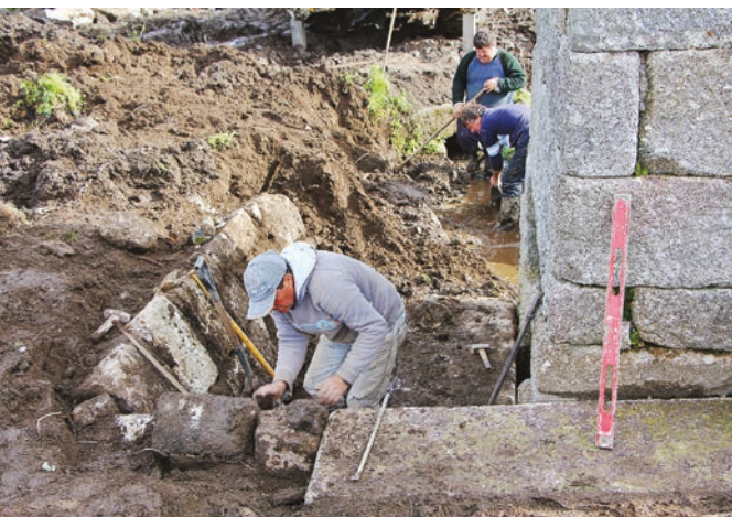
FIGURA 61. Trabalhos de construção dos muros de delimitação da presa.
