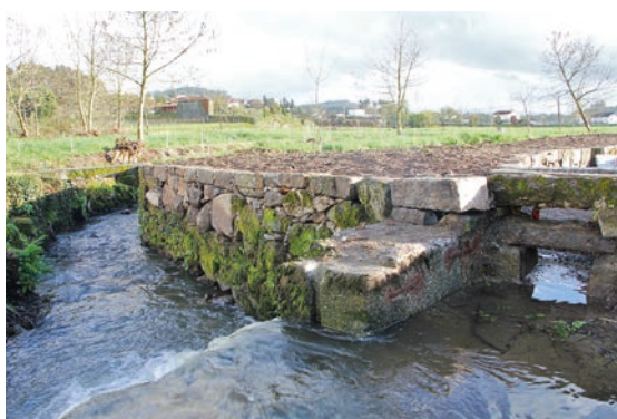
FIGURAS 36 E 37. Reconstrução do muro na margem direita do rio Mezio, a montante do açude.
