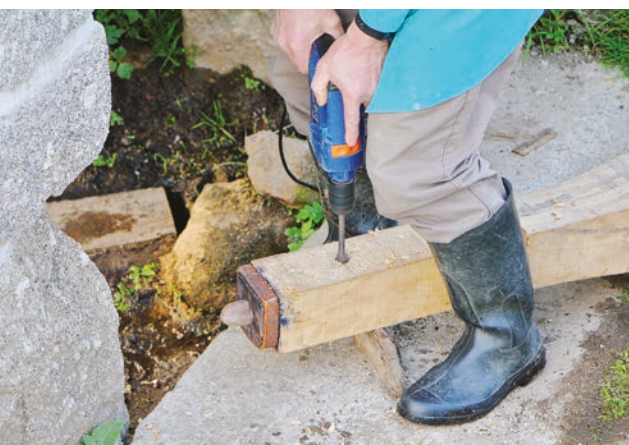
FIGURAS 131 E 132. Abertura de orifício na pela para suporte do novo rodízio.
