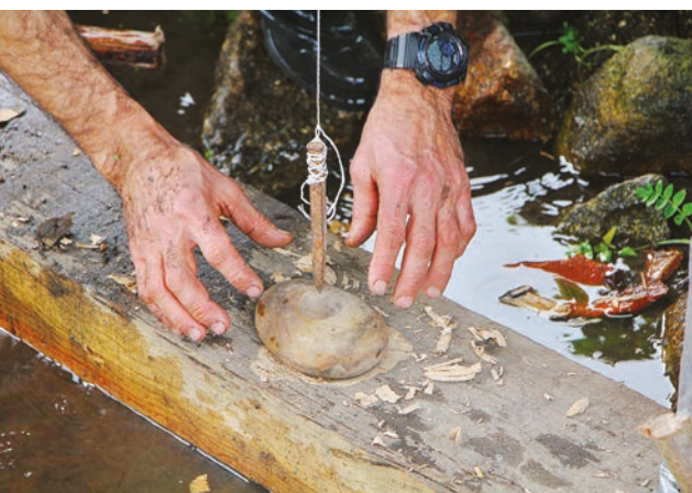
FIGURA 122. Verificação da posição da rela na ponte.
