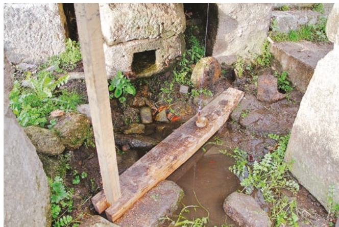
FIGURA 119. Pormenor da união do alçadoiro à ponte.
