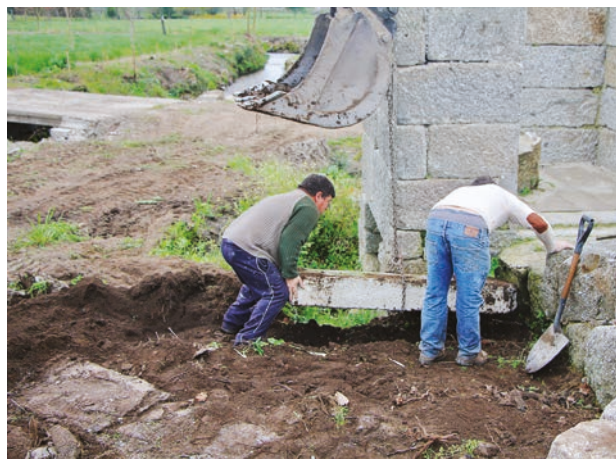
FIGURA 60. Trabalhos de edificação dos muros de delimitação dos caboucos do moinho.
