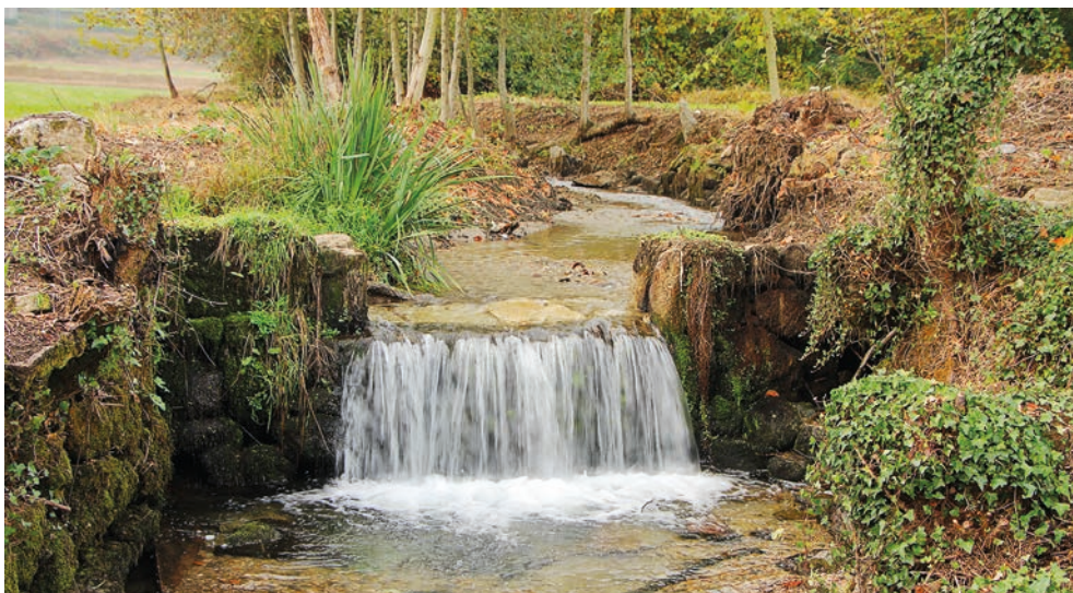
FIGURA 35. Pormenor do sistema de captação de água (açude) existente no rio Mezio no início dos trabalhos de limpeza.
