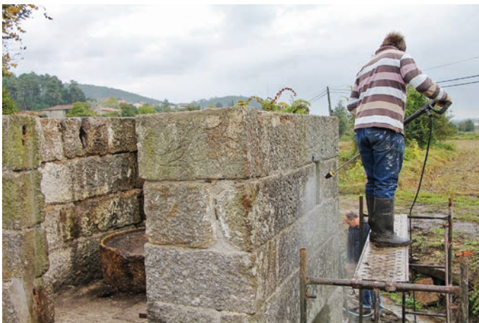
FIGURAS 26 E 27. Trabalhos de limpeza com jato de água no exterior e interior do moinho.
