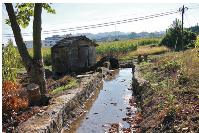
FIGURA 19. Aspeto da estrutura de moagem hidráulica, do sistema de admissão e do sistema de condução após as ações de desmatção da vegetação arbustiva.
