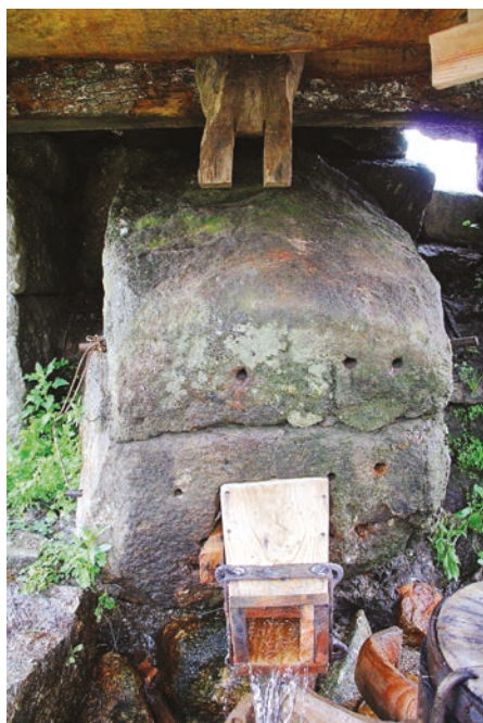
FIGURA 147. Fixação da nova seteira ao cubo através de um aro metálico.
