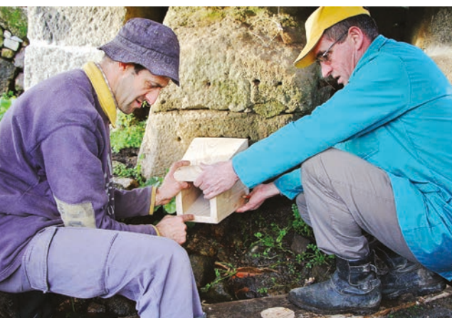
FIGURA 145. Reposição da nova seteira no cubo.
