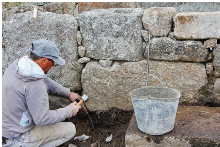
FIGURAS 48 E 49. Pormenor dos trabalhos de reconstrução da escadaria de acesso à ponte, erigida a montante do lavadouro.
