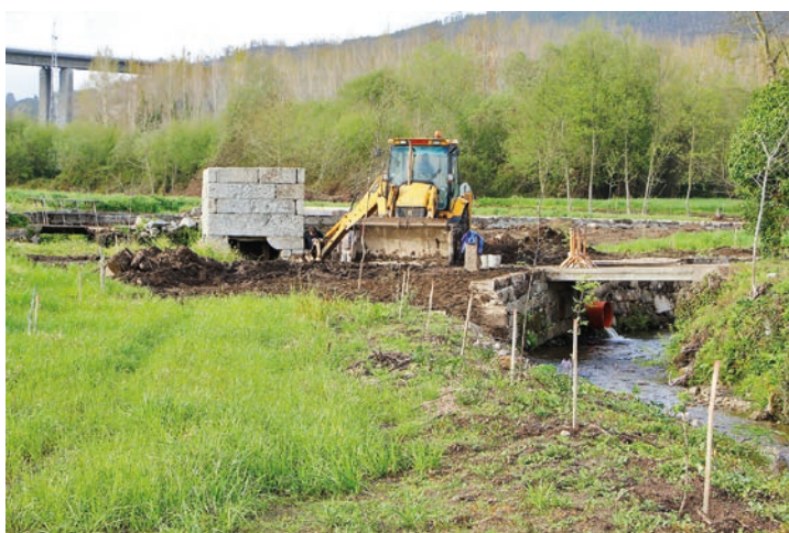
FIGURA 22. Trabalhos mecânicos de remoção das terras na envolvente sudoeste a nordeste do moinho.
