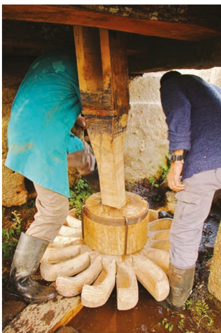
FIGURAS 141 E 142. Ação de montagem da pela, do lobete e do rodízio nos caboucos do moinho.
