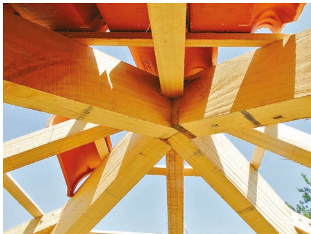
FIGURA 66. Pormenor do sistema de cobertura do moinho (exterior).
