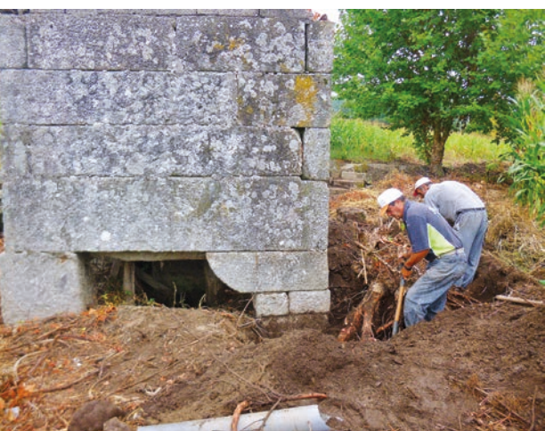
FIGURA 21. Trabalhos de limpeza dos caboucos do moinho.
