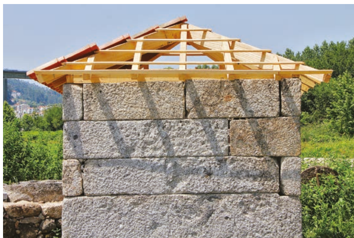
FIGURA 67. Pormenor do sistema de cobertura do moinho (exterior).
