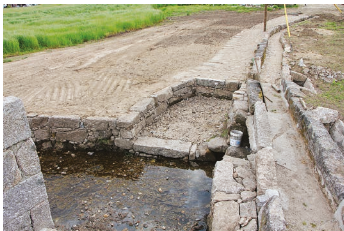
FIGURA 59. Aspetto final da calçada, do limite sudoeste da levada e da presa.
