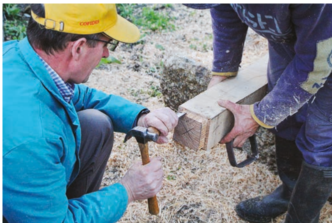
FIGURA 127. Execução de sulco na base da pela para permitir a colocação de uma argola metálica.
