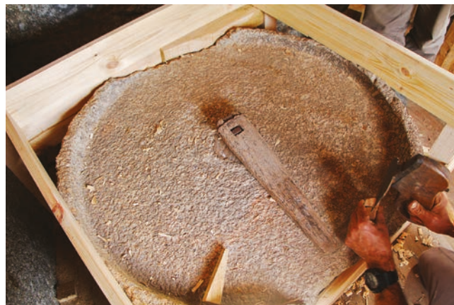
FIGURA 89. Trabalhos de nivelamento/ajustamento da mó dormente.
