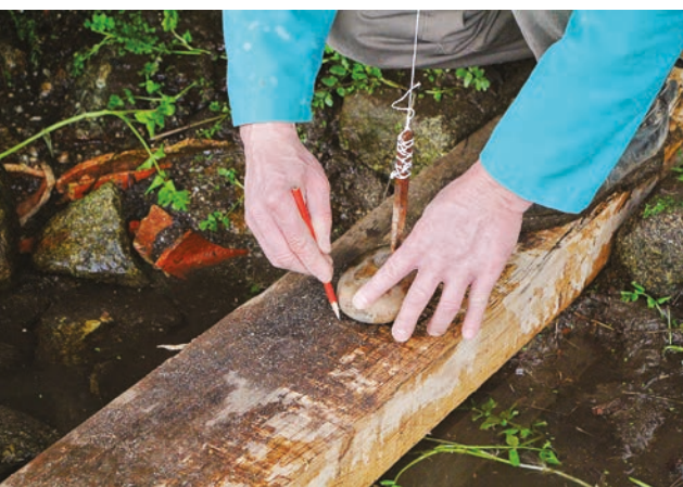
FIGURA 120. Marcação do encaixe da rela na ponte.
