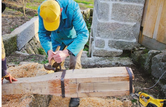
FIGURA 126. Colocação das abraçadeiras metálicas de reforço na pela.
