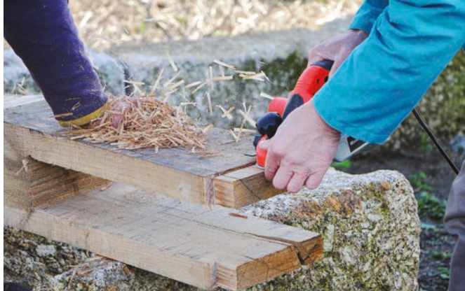
FIGURA 125. Desbaste do topo da pela para a criação da forma em U.
