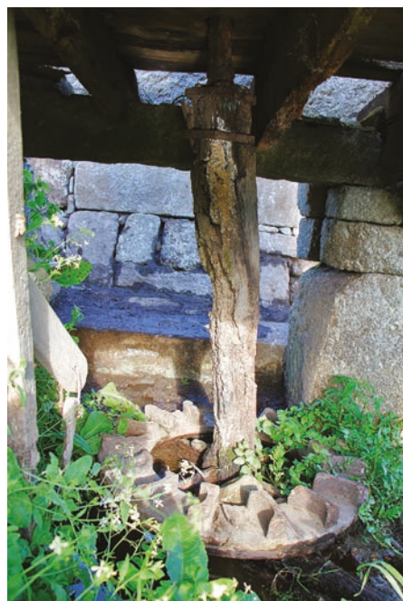
FIGURA 110. Pormenor do mecanismo motor do Moinho do Ribeiro antes dos trabalhos de restauro.
