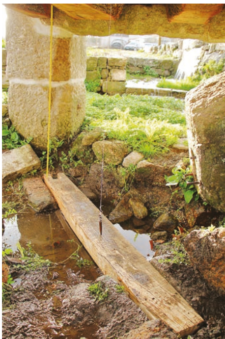
FIGURA 118. Aspeto inicial dos trabalhos de instalação da ponte.
