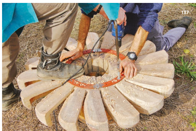
FIGURA 136. Fixação das penas no novo rodízio.
