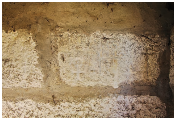
FIGURA 28. Trabalhos de picagem dos excedentes das juntas do aparelho do moinho.
