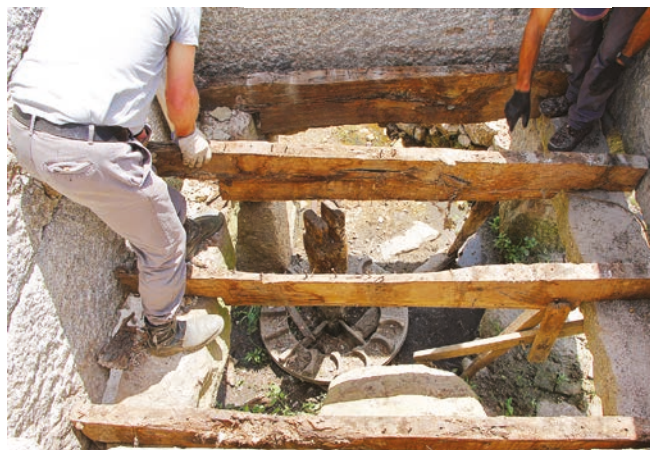
FIGURA 70. Trabalhos de remoção das traves de madeira existentes no piso de moagem.
