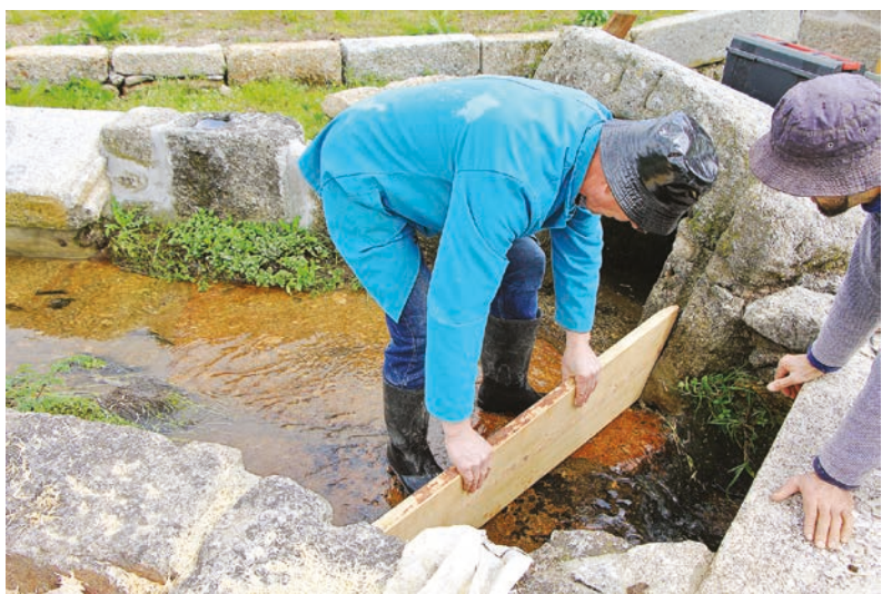
FIGURA 151. Colocação das comportas na levada.
