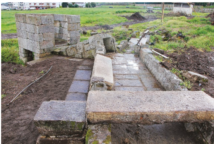
FIGURA 50. Aspeto final dos trabalhos na área correspondente ao lavadouro.
