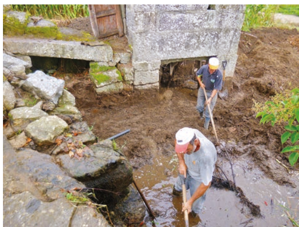
FIGURA 24. Trabalhos manuais de remoção das terras na envolvente sudoeste do moinho.
