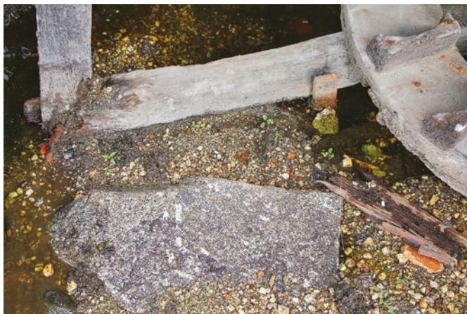
FIGURA 115. Pormenor da união do alçadoiro à ponte.
