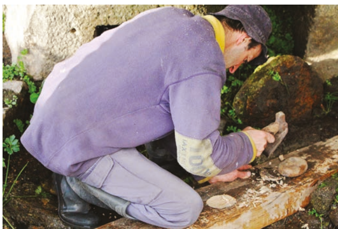
FIGURA 121. Escavação da cama para a rela na ponte.
