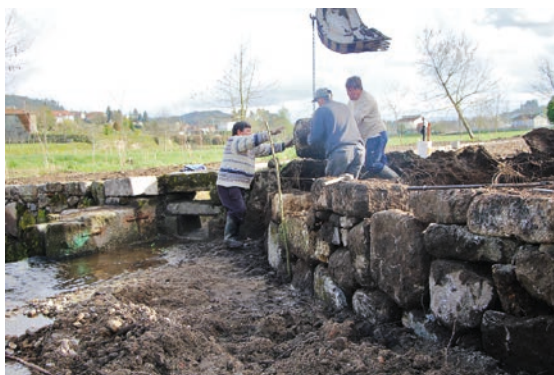
FIGURAS 36 E 37. Reconstrução do muro na margem direita do rio Mezio, a montante do açude.
