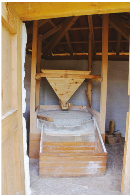
FIGURA 103. Trabalhos de aplicação da quelha.
