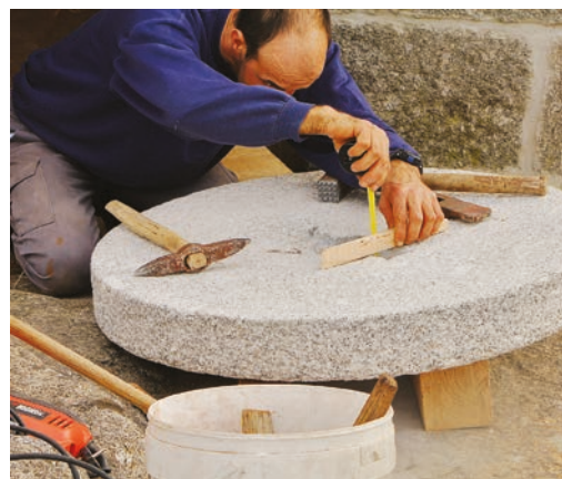
FIGURAS 95 E 96. Trabalhos de execução da marca de alinhamento na mó andadeira (em forma de cruceiro).
