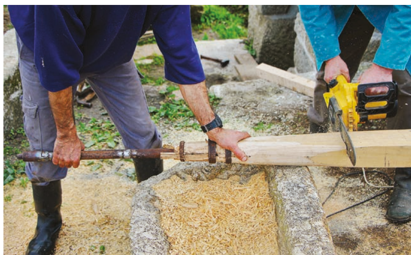
FIGURA 133. Corte do lobete para encaixe na pela.
