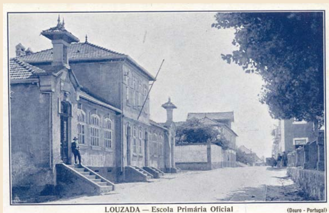
Fig. 7 - Edifício da antiga escola primária da Vila de Lousada, projecto-tipo da autoria de Adães Bermudes, cuja construção se iniciou em 1901. No largo fronteiro, vulgarmente conhecido por Campo da Feira, realizou-se, até aos finais dos anos trinta, a feira quinzenal. Ao fundo o edifício do prestigiado estabelecimento “A Comercial”, propriedade de J. Mota & Filho.
