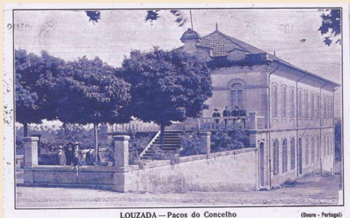
Fig. 6 - O projecto de remodelação e ampliação do edifício dos Paços do Concelho foi da autoria do Arq. António Sanches. Em Janeiro de 1913 o projecto foi aprovado e em Maio desse ano as obras foram arrematadas e adjudicadas. Temporariamente os serviços da câmara funcionaram num edifício arrendado a Luís Lopes, no antigo largo da feira. As obras da entrada principal arrastaram-se por vários anos: em 1920 ainda se reclamava contra o acesso feito através de tábuas.
