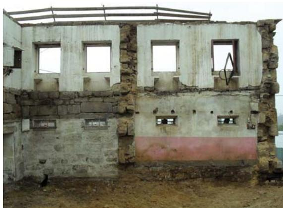
**Figura 6** - Perspectiva interior da fachada Sul do Salão Paroquial após a demolição das paredes internas e parede exterior poente (à direita).
