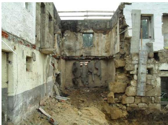
**Figura 5** - Interior da área Norte/Este do edifício durante a fase de demolição, correspondente a uma ampliação que reconfigurou a volumetria do edifício.
