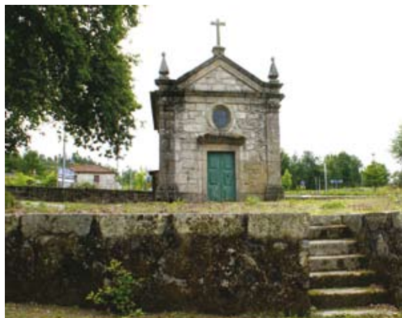
Figura 2. Perspectiva geral de implantação da Capela de São Bartolomeu.
