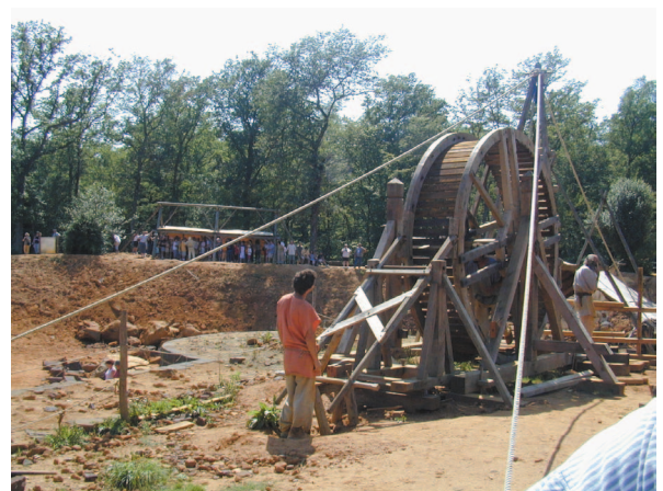
Figura 26. Aspecto geral do uso da grande roda empregue na elevação da pedra, a partir do projecto de Arqueologia Experimental "Chantier Médiéval de Guédelon", Treigny, França (2004).
