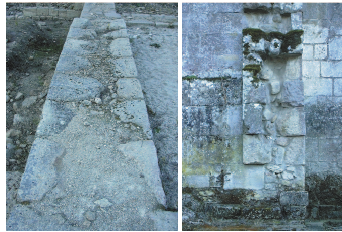
Figura 34. Aspecto em secção da técnica de construção das paredes na área das dependências monásticas do Mosteiro de S. João de Tarouca.
