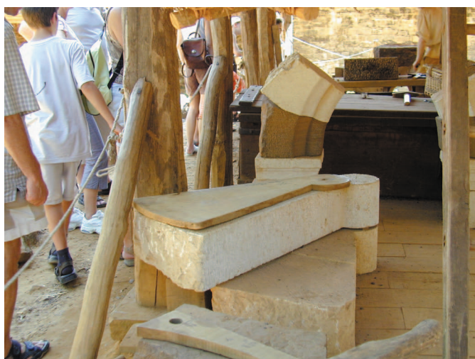
Figura 19. Aspecto geral do emprego de cêrceas de madeira na obtenção de elementos arquitectónicos complexos, a partir do projecto de Arqueologia Experimental "Chantier Médiéval de Guédelon", Treigny, França (2004).
