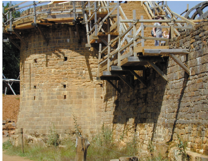
Figura 29. Aspecto geral do uso de andaimes dependentes, a partir do projecto de Arqueologia Experimental "Chantier Médiéval de Guédelon", Treigny, França (2004).
