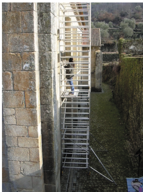
Figura 58. Aspecto geral dos trabalhos de análise litológica do alçado sul da igreja do Mosteiro de S. João de Tarouca.
