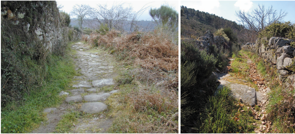
Figura 52. Exemplo de calçadas ainda preservadas na encosta de Mondim da Beira e Aldeia do Couto, sendo que à direita se observa uma profunda marca de rodado.
