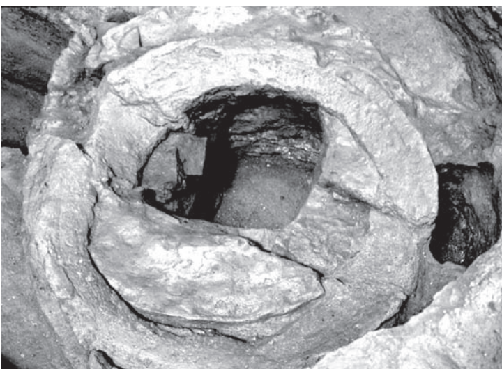
Figura 3. Pormenor dos canais de circulação do ar (F. Vidinha). (Tratamento da imagem CAPTA Fotografia).
