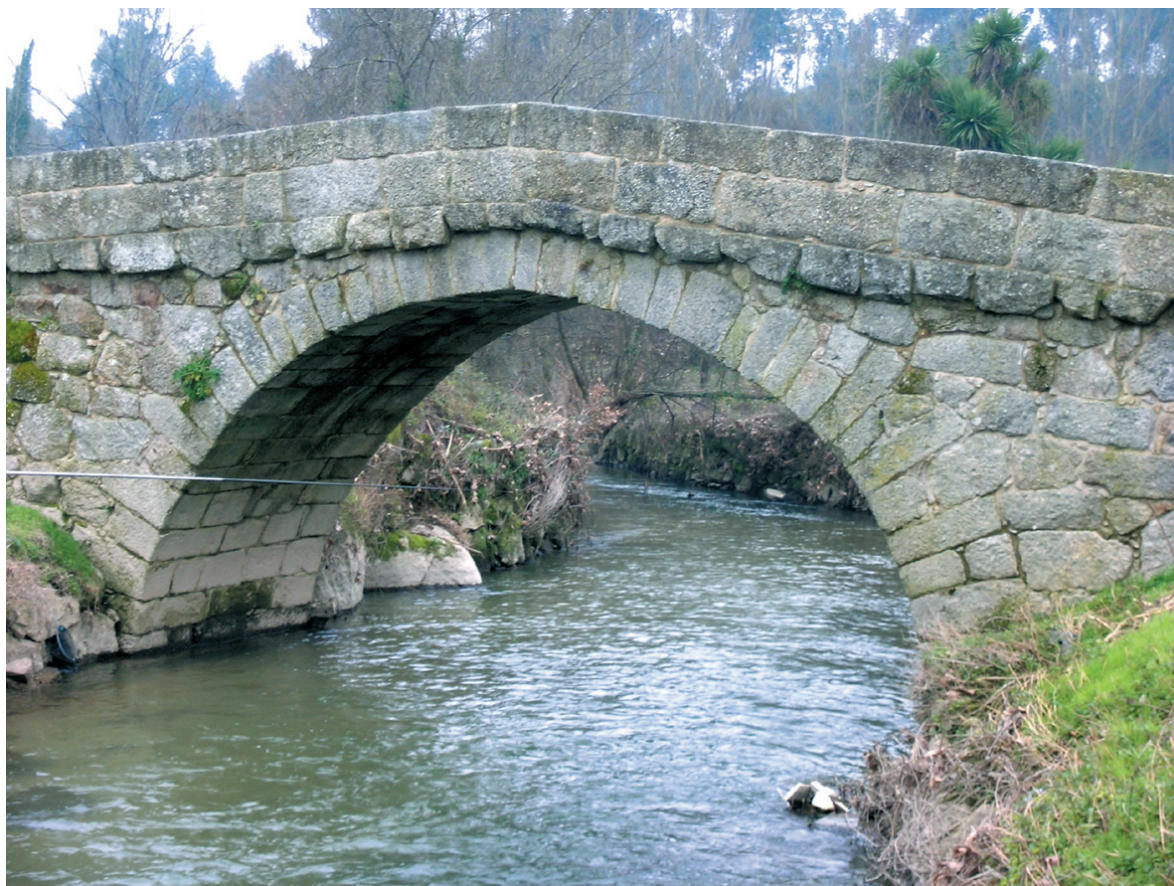
Figura 20. Ponte de Espindo em leve cavalete. Baixa Idade Média.
