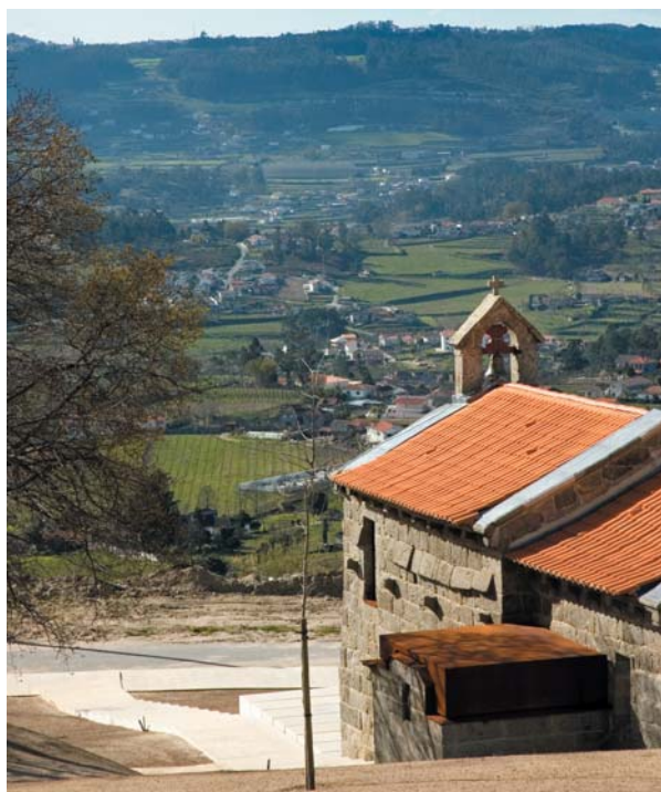
Figura 2. (Igreja de S. Mamede de Vila Verde, Felgueiras – Depois das obras de recuperação, conservação e salvaguarda, 2007)
