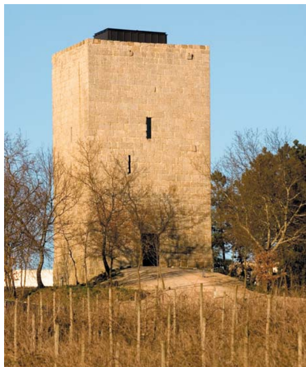
Figura 4. (Torre de Vilar, Lousada – Depois das obras de recuperação, conservação e salvaguarda, 2007)
