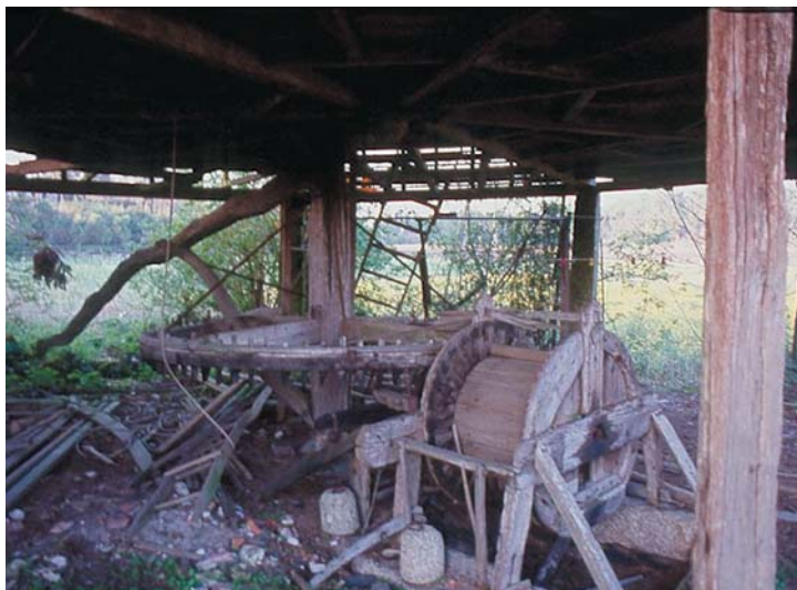
Figura 8. Engenho de maçar linho. Mesão Frio, Galegos, 2002
