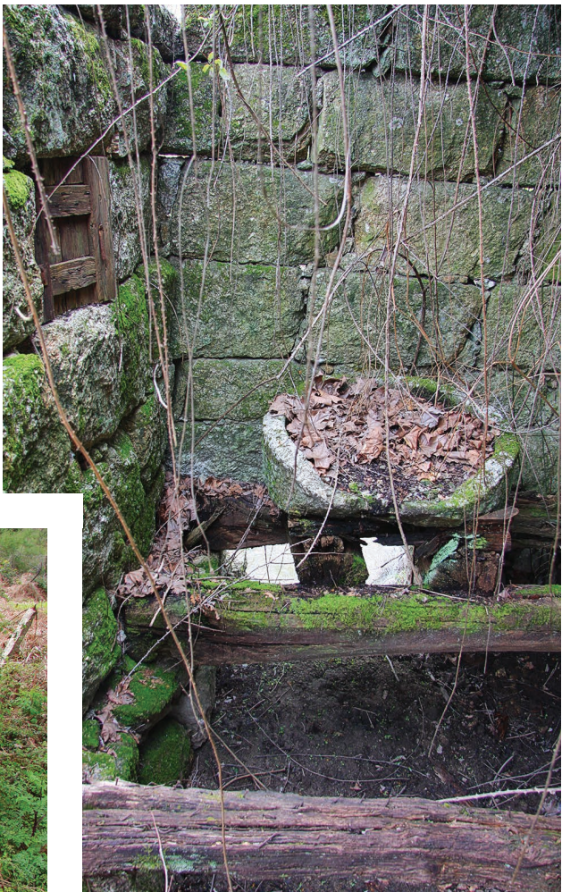
FIGURA 15. Vista interior do Moinho de Ronfe 3 (n.º 98), destituído de pavimento e dos respetivos sistemas de engrenagem associados ao mecanismo motor e de moagem.
