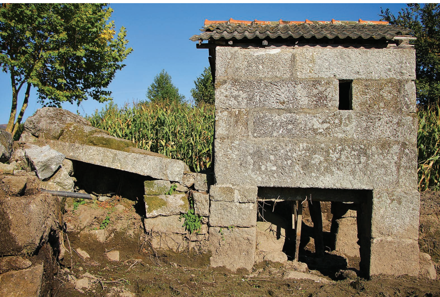
FIGURA 16. Alçado sul do Moinho do Ribeiro (n.º 25), em Sousela, nas margens do rio Mezio. É perceptível a estruturação do edifício em dois pisos, com a admissão de água (cubo) situada a uma cota superior aos caboucos.
