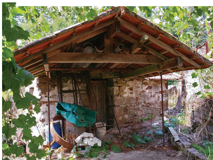
▲ FIGURA 25. Engenho de serração de Pias (Moinho do Engenho, n.º 57), que, além do sistema de serração de madeira, integrava, igualmente, um moinho de rodízio acionado por uma caleira em pedra (granito), com cobertura.
