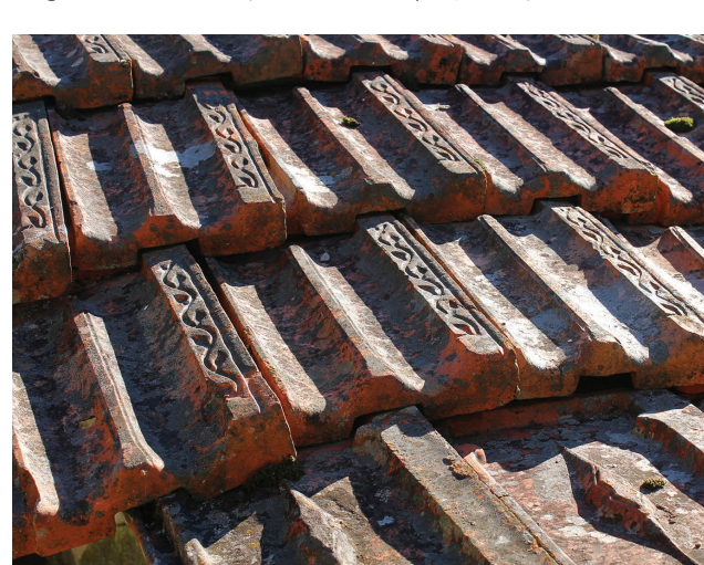
FIGURA 23. Telhado com telha francesa (Moinho de Pontarrinhas 2, n.º 118).
