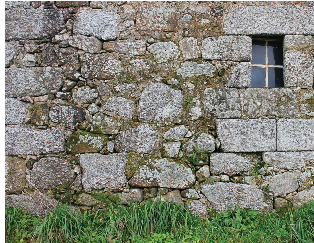
FIGURA 19. Aparelho misto de granito (Moinho da Magantinha, n.º 170).
