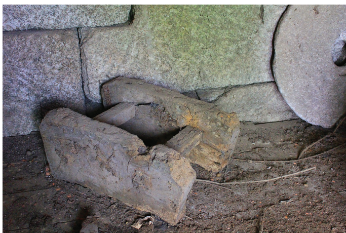
FIGURA 38. Escada de acesso à dorneira (Moinho da Casa de Vila Verde 3, n.º 214).
