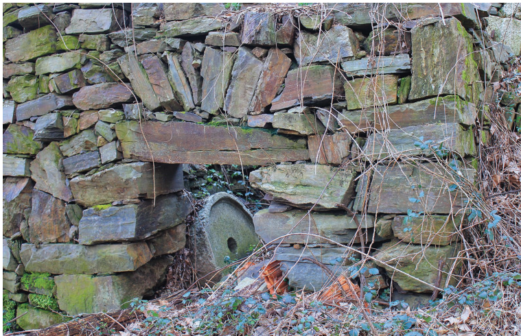
FIGURA 20. Aparelho não estruturado, com recurso a litologia de corneana (Moinho de Casas Novas 2, n.º 183).
