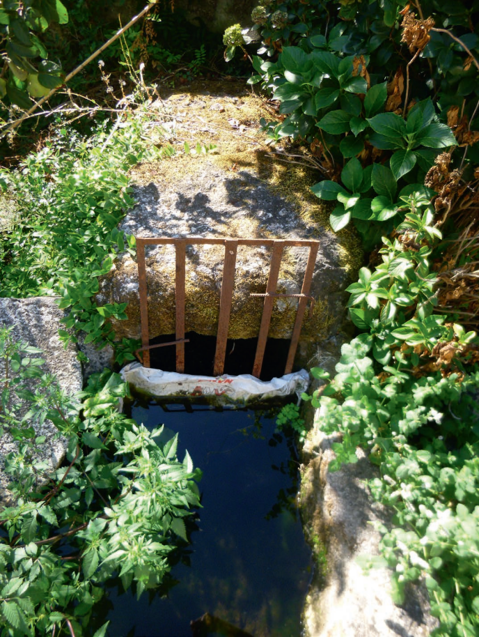
FIGURA 52. Cubo tubular quadrangular do Moinho do Casal 1 (n.º 122), com sistema de filtragem (grade metálica).
