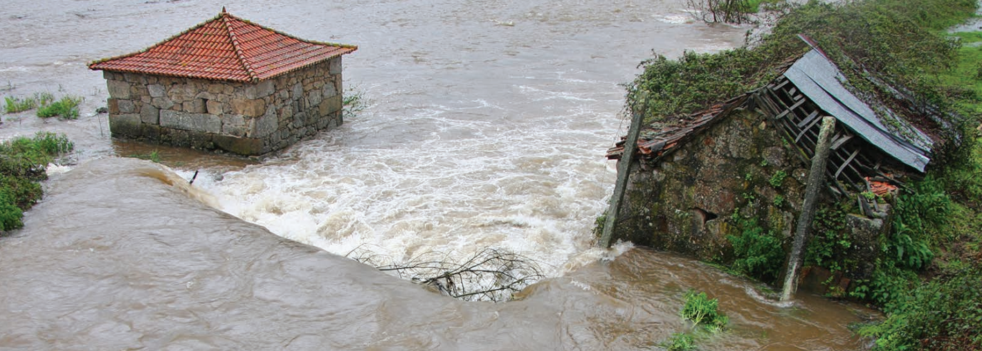
FIGURA 11. Cheia no rio Mezio (inverno de 2013) que submergiu o núcleo dos moinhos da Ponte, em Lagoas (Nevogilde).
