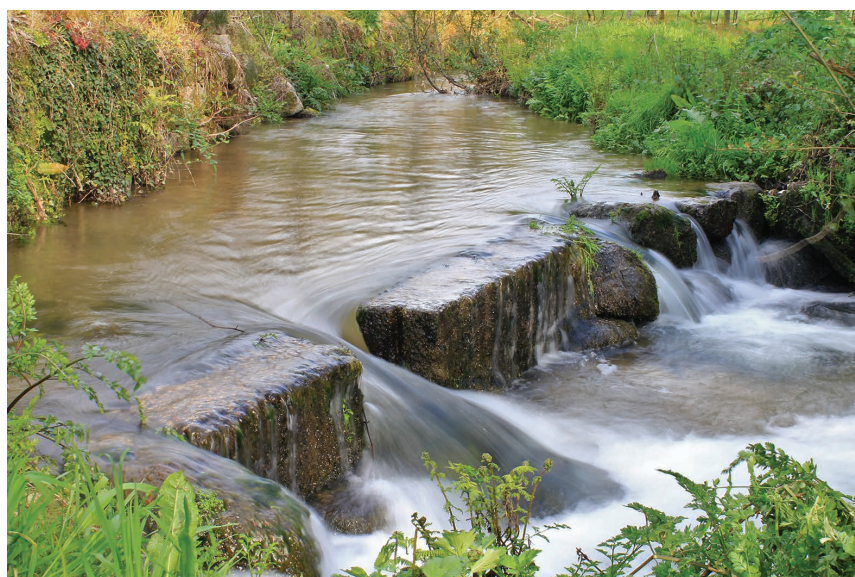
FIGURA 43. Açude alto, reto e perpendicular (núcleo de moinhos da Ponte, rio Mezio).
