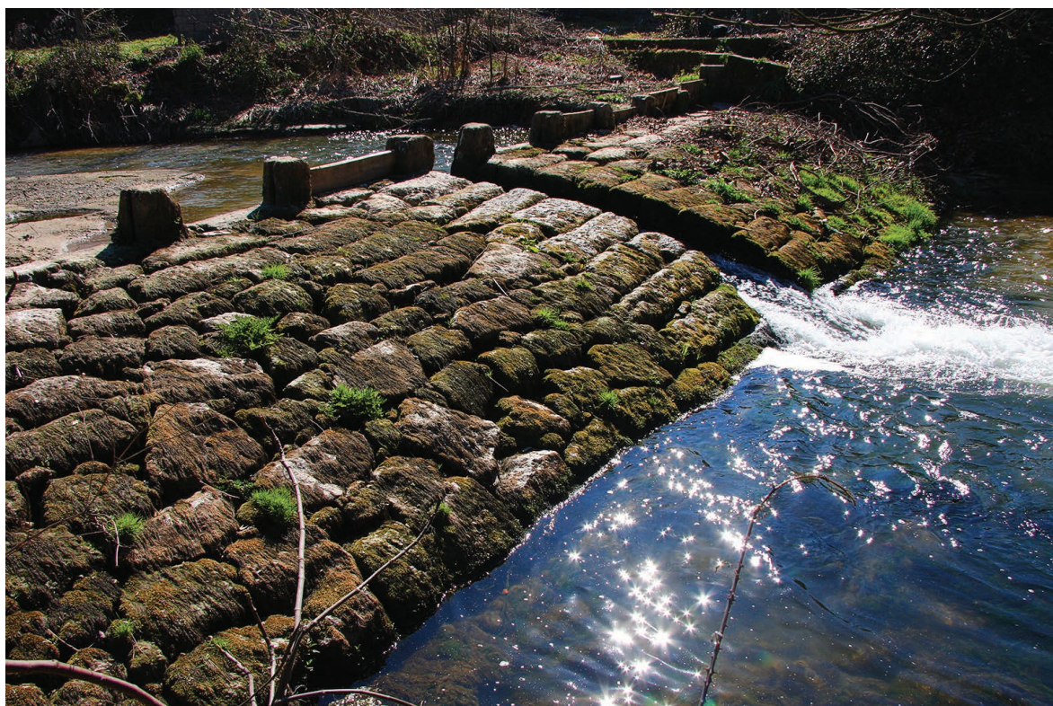
FIGURA 42. Pormenor do aparelho do açude que abastece o Moinho da Quinta da Azenha (n.º 46) (rio Sousa).
