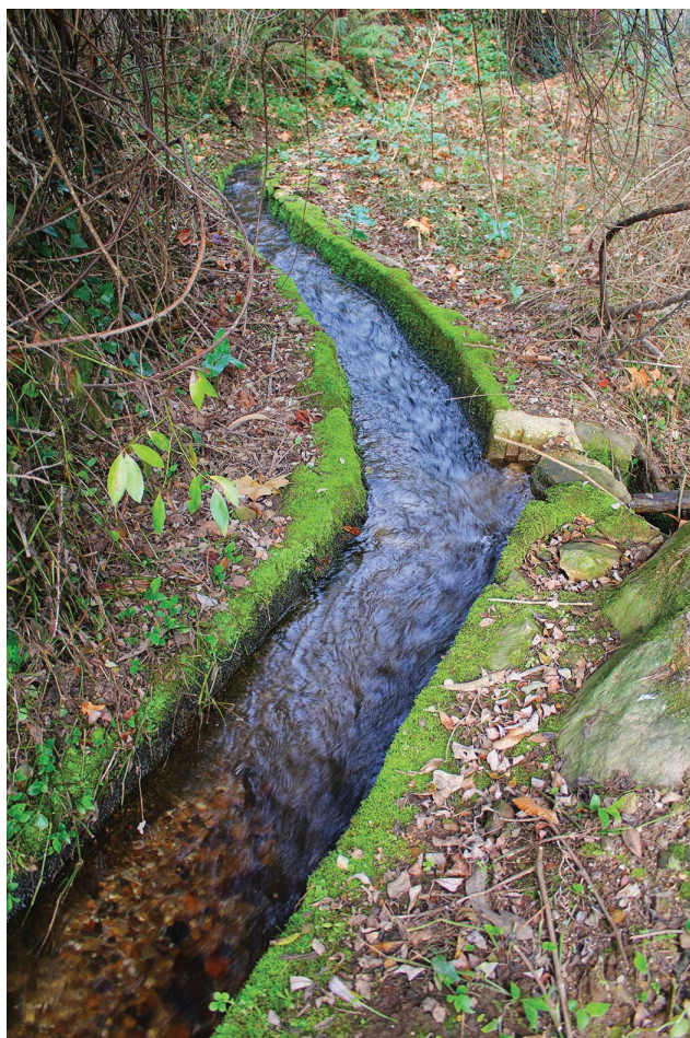
FIGURA 46. Levada estruturada em meias canas de cimento (Moinho da Quinta de Arranhol, n.º 156).
