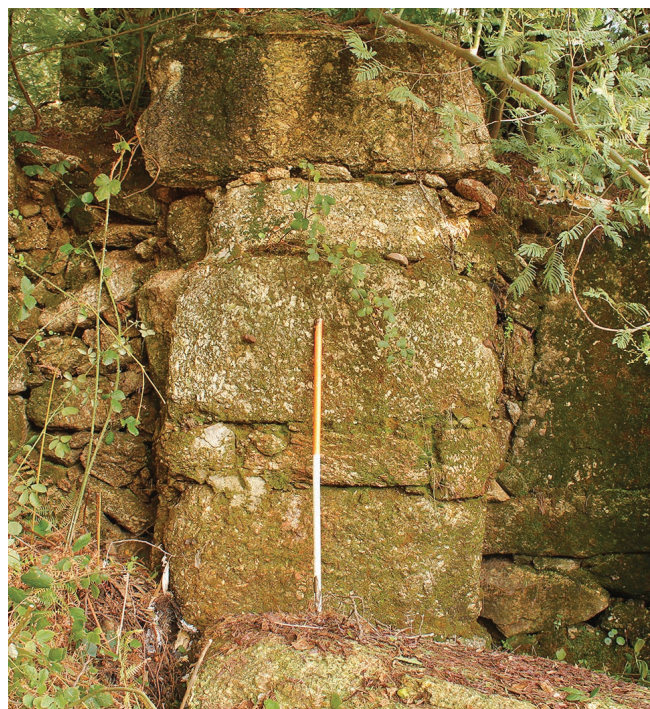
FIGURA 50. Cubo tubular quadrangular vertical do Moinho da Bouça (n.º 148), em Sousela.
