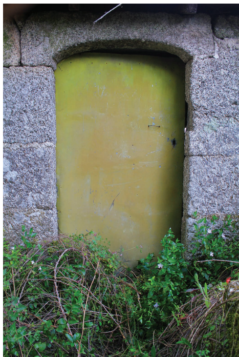
FIGURA 29. Porta de uma folha (metálica), com padieira curva (Moinho da Casa de Vila Verde 3, n.º 214).
