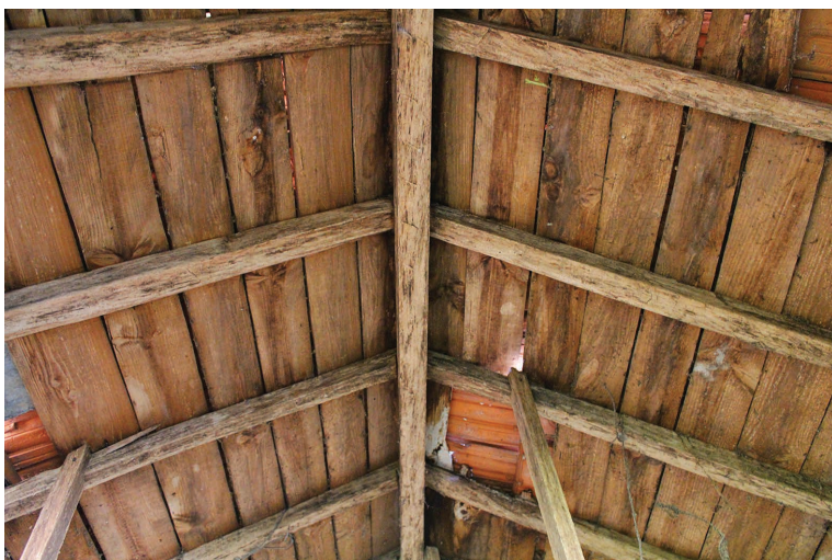
FIGURA 22. Cobertura com forro interior (Moinho de Pontarrinhas 2, n.º 118).
