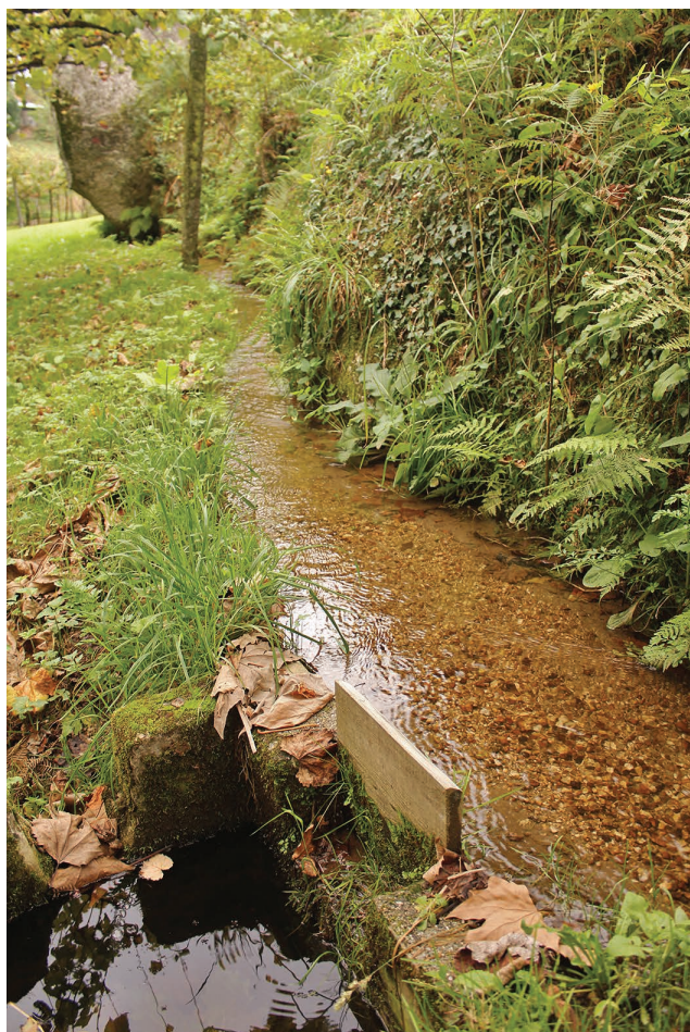
FIGURA 45. Exemplo de levada aberta diretamente no geológico, com rebordo em terra e sistema de controlo de água com recurso a tacos de madeira (Moinho do Guedes, n.º 148).
