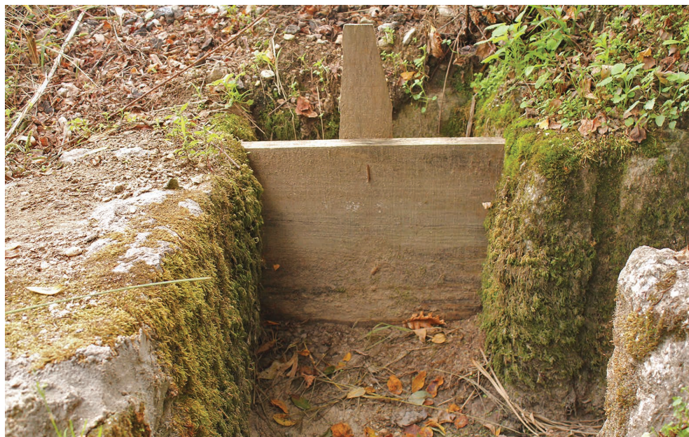
FIGURA 47. Troço de levada do Moinho da Quinta de Cedovezas (n.º 128), com sistema de gestão e corte do fluxo (taco de madeira) de água.
