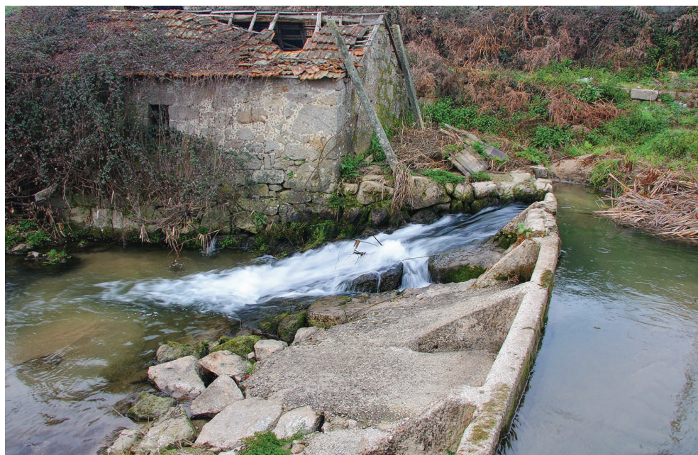
FIGURA 43. Açude alto, reto e perpendicular (núcleo de moinhos da Ponte, rio Mezio).
