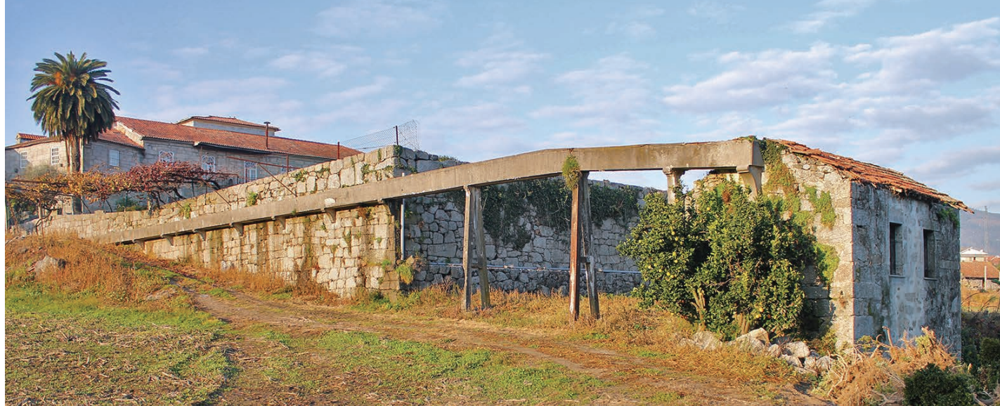
FIGURA 48. Vista geral da levada sobrelevada e respetivo sistema de admissão do Moinho da Casa de Rio de Moinhos (n.º 155).
