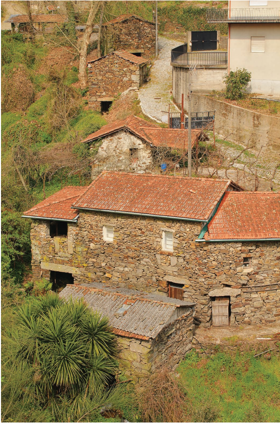
FIGURA 51. Moinhos em sucessão no ribeiro de Barrosas. O aproveitamento sucessivo da energia gravítica da água determinou a utilização de um sistema de cubos tubulares, para aumentar a energia potencial disponível entre as moagens.
