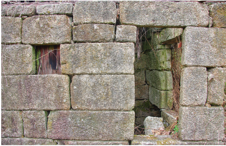
FIGURA 18. Aparelho em perpiano de granito (Moinho de Ronfe 3, n.º 98).
