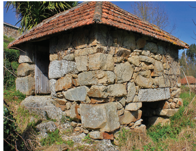
FIGURA 21. Exemplo de estrutura de moagem com aparelho não estruturado, com recurso a litologias mistas de granito e corneana (Moinho do Campo 1, n.º 171).
