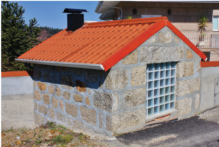
FIGURA 13. Moinho da Vinha do Moinho (n.º 199) após as obras de reconversão (Meinedo).
