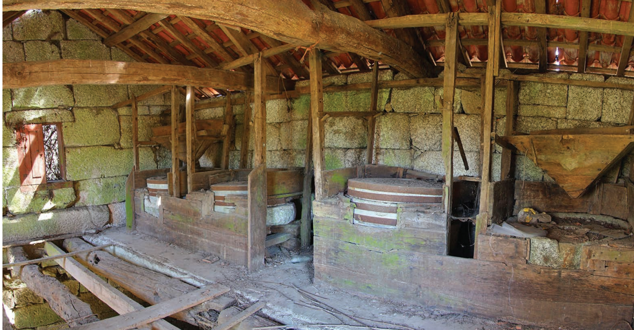
FIGURA 7. Vista interior do Moinho da Quinta da Azenha (n.º 46), no rio Sousa, onde são perceptíveis os quatro casais de mós existentes.
