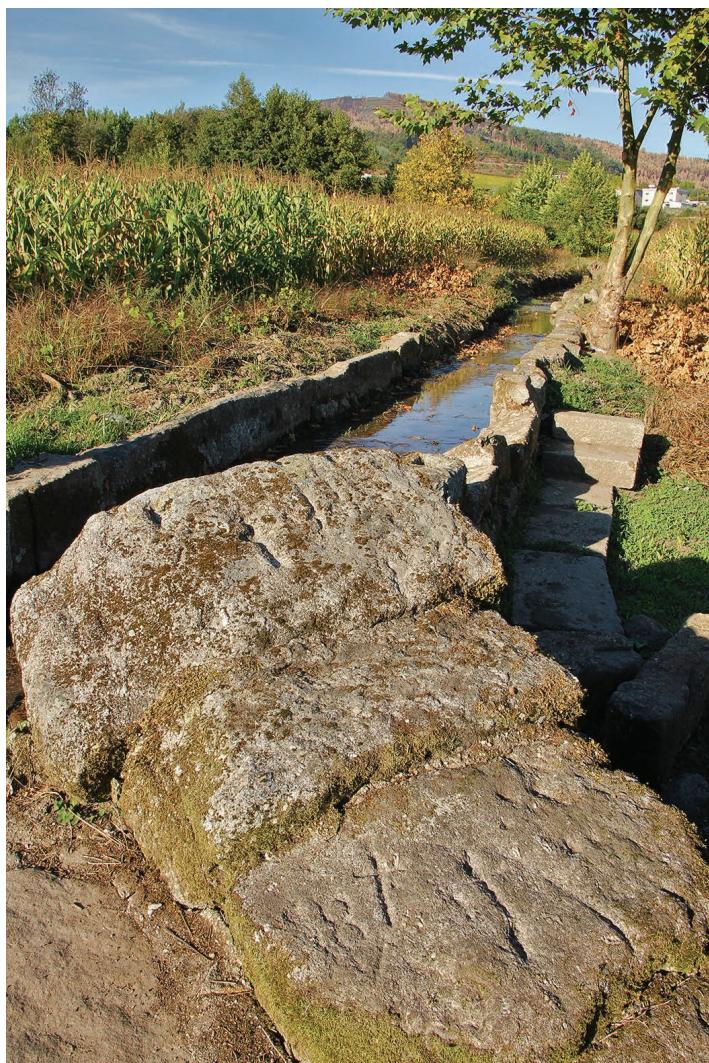
FIGURA 49. Vista geral do cubo quadrangular do Moinho do Ribeiro (n.º 25), com a respetiva levada em pedra.
