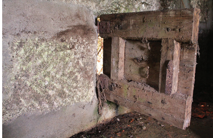
FIGURA 28. Janela com cerramento de vão em madeira (Moinho de Romariz 1, n.º 134).
