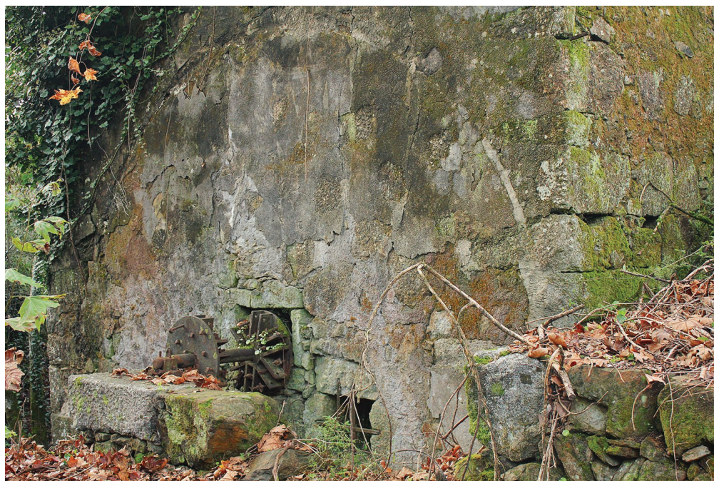
FIGURA 17. Alçado sudeste do Moinho de Lourosa 2 (n.º 145), onde é perceptível o negativo da roda vertical, que rodaria no eixo metálico situado ao centro da gola.
