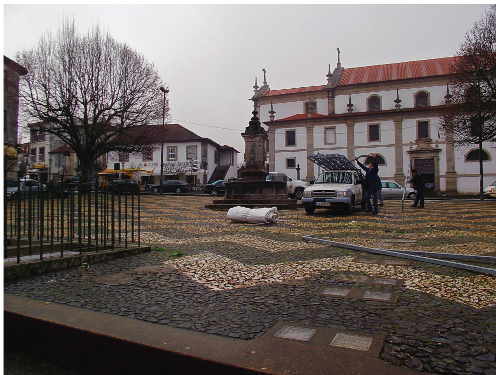
FIGURA 6. Praça Brandão de Vasconcelos em fase de preparação dos trabalhos arqueológicos, enquadrada pela Igreja do Mosteiro de Arouca.
