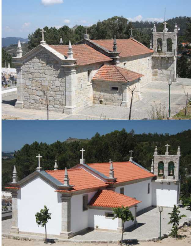
FIGURA 3 Aspeto geral da Capela do Senhor do Padrão antes e depois das obras de restauro do edifício [2015].
