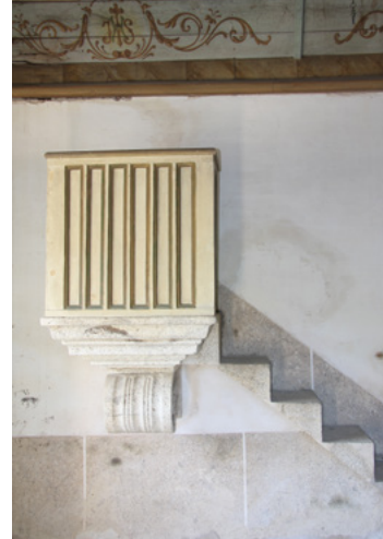
FIGURA 7 Aspeto do púlpito da capela adossado à parede norte do edifício.
