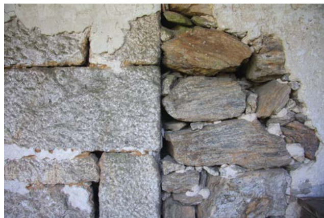
Figura 2. Pormenor de duas tipologias de aparelho (Casa do Carmo) onde o granito e a corneana marcam épocas e tecnologias distintas de construção.
