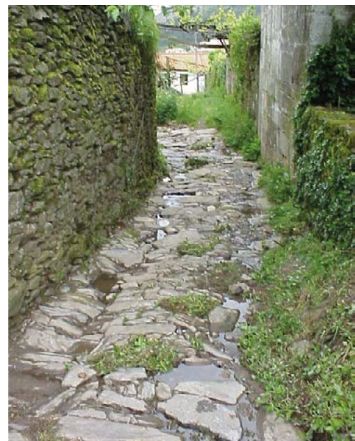
Figura 6. Aspeto da Calçada do Carmo (acesso à casa) no final dos anos 90 do século XX.
