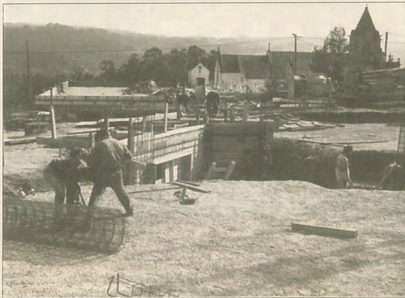
Construção do Reservatório de Lodes: água do Tâmega chegará no Verão
