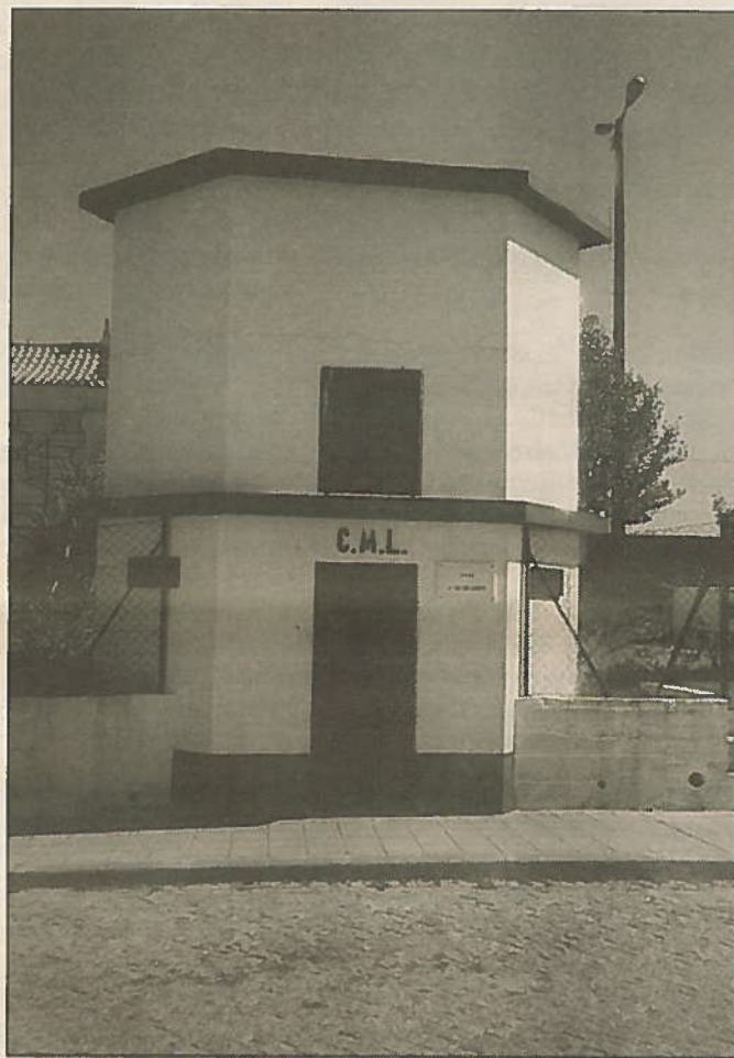
Reservatório do Loreto já recebe água do Tâmega
