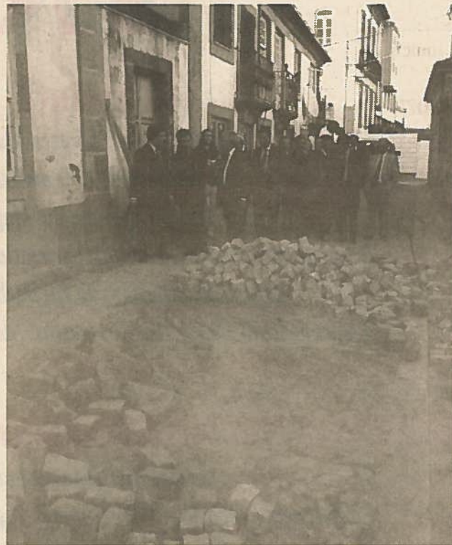
Obras na Rua de Santo António são importante apoio ao comércio.
