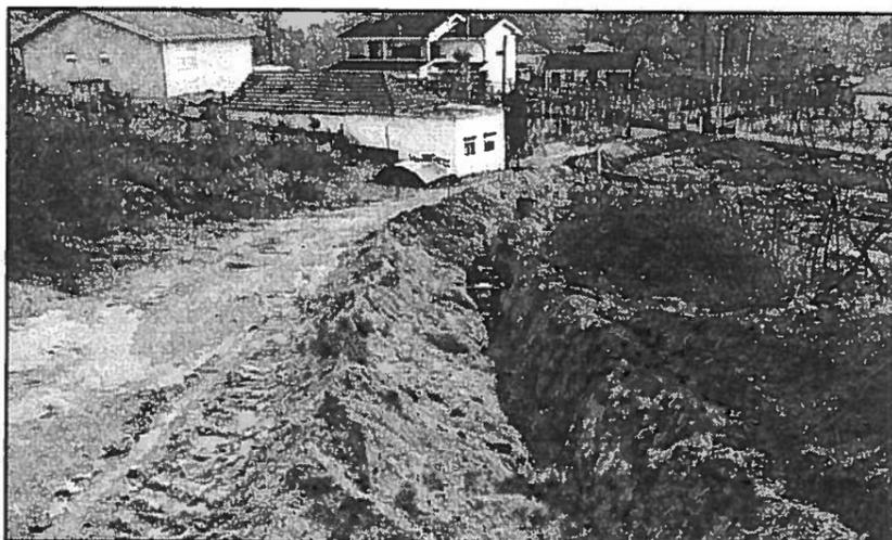
**Obras por administração directa concluídas** – EN 106-1, Lousada e outras intervenções em várias zonas do concelho. Decorrem as obras da rede de esgotos da EN106-1 até ao Lugar do Cruzeiro, Boim, que inclui a construção de uma estação elevatória de esgotos.
