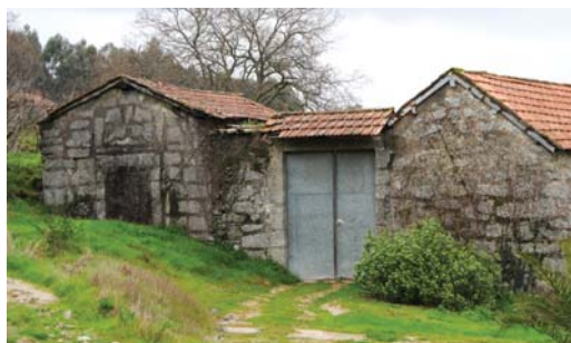
Fig. 3 - Capela de São Roque na Casa do Bairro. Edifício à esquerda do portal carral.
