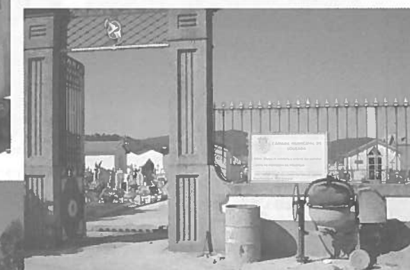
Beneficiação no cemitério de Figueiras
