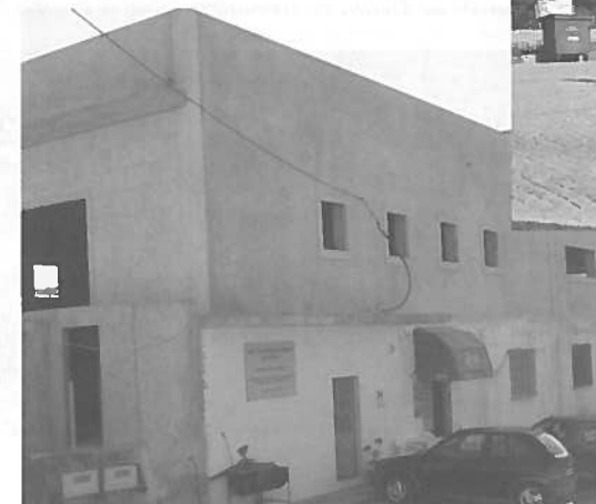
Construção da sede da Junta de Alvarenga
