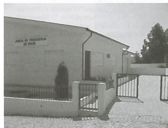
Ampliação da Sede da Junta
