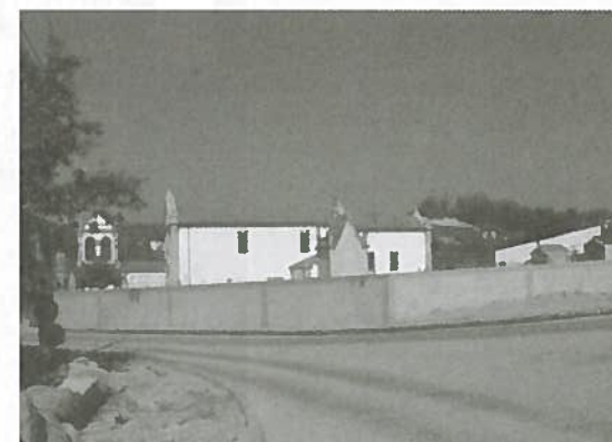
Construção do muro devido ao alargamento do cemitério, Pias
