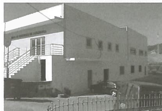
Construção da sede da Junta
