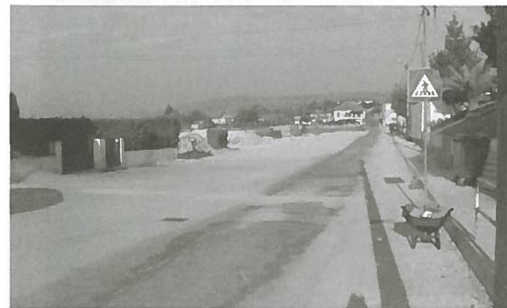
Construção do separador central em Roupas, Lousada
