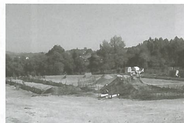
Construção do ginásio desportivo, Meinedo
